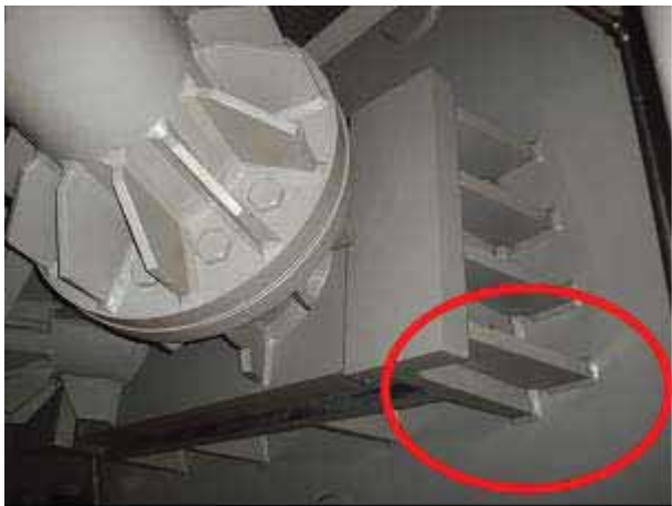
上部シヤラグ 耐震強化工事の概要 (左：強化前, 右：強化後)
