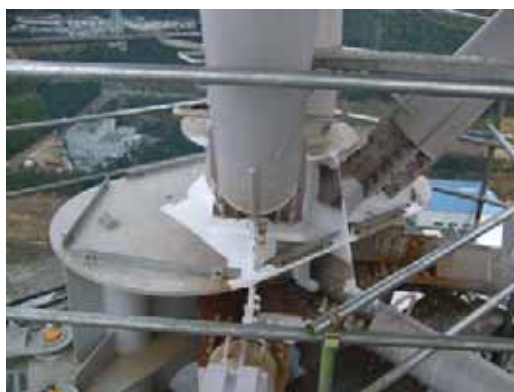
既存支柱材と追加柱材の連結部の状況 (T.M.S.L. +105m 付近：最終塗装前)
