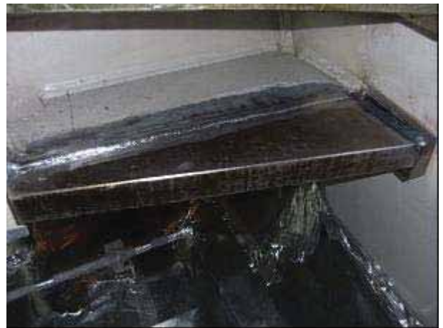
上部シヤラグ 耐震強化工事の概要 (左：強化前, 右：強化後)
