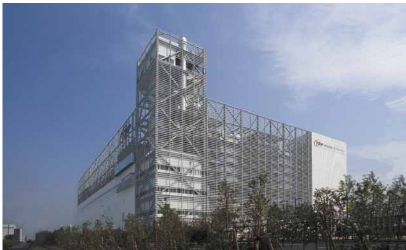
東京臨海リサイクルパワーの外観
