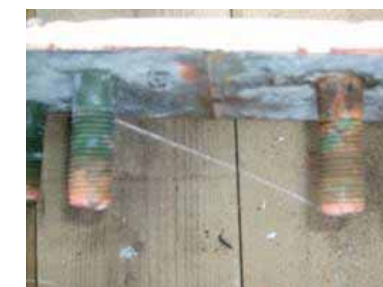
E側ボルト
