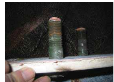
N側ボルト
