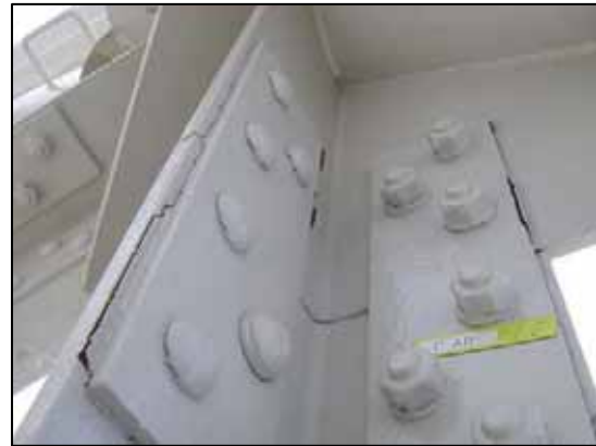
塗膜剥離状況④
