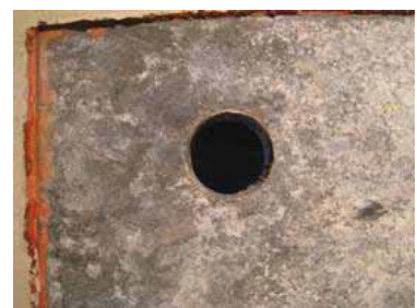
N側 E面母材ボルト孔
