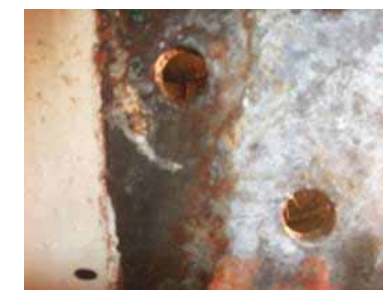
E側S面母材ボルト孔
