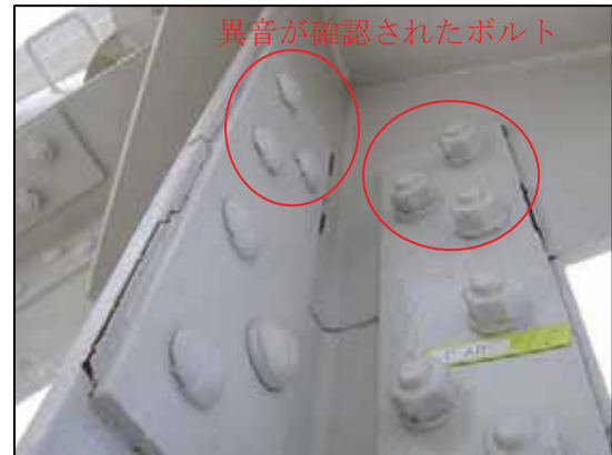
異音確認箇所写真
