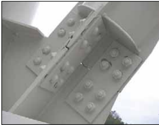
塗膜剥離状況①
