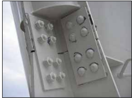
塗膜剥離状況②
