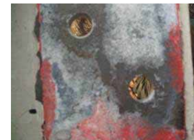
S側W面母材ボルト孔
