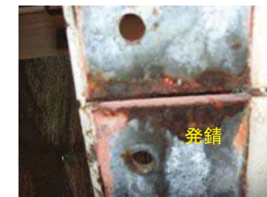
W側S面母材ボルト孔
