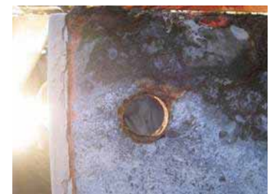
N側 E面母材ボルト孔
