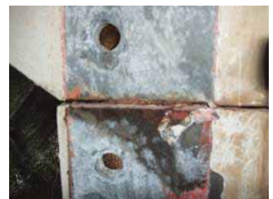
S側E面母材ボルト孔
