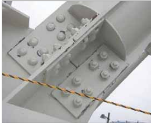
塗膜剥離状況③
