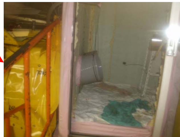
撮影：東京電力 撮影日時：平成23年6月11日 午前11時頃 撮影場所：福島第一2号機タービン建屋内 [北側エアハウス内] *カメラを養生しているビニールの中から撮影
