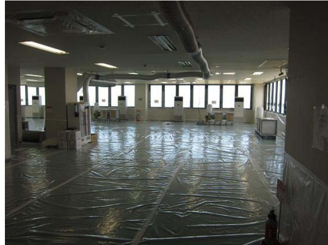
撮影日 : 平成23年6月30日 15時頃 場所 : 休憩所内部
