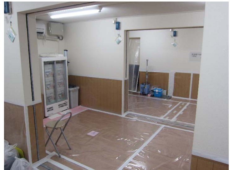
撮影日 : 平成23年7月2日 11時頃 場所 : 休憩所内部
