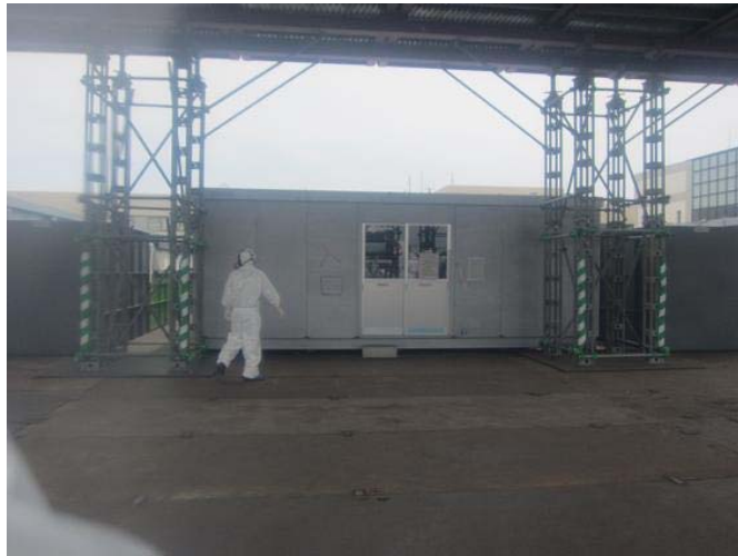
撮影日 : 平成23年6月12日 11時頃 場所 : 休憩所外観
