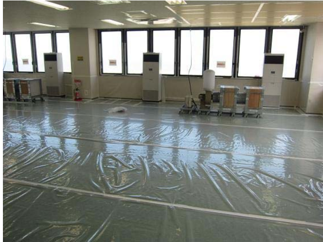
撮影日 : 平成23年6月30日 15時頃 場所 : 休憩所室内部
