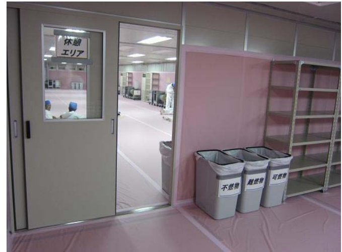
撮影日 : 平成23年6月13日 12時半頃 場所 : 休憩所出入口
