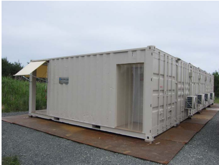
撮影日 : 平成23年7月2日 11時頃 場所 : 休憩所外観
