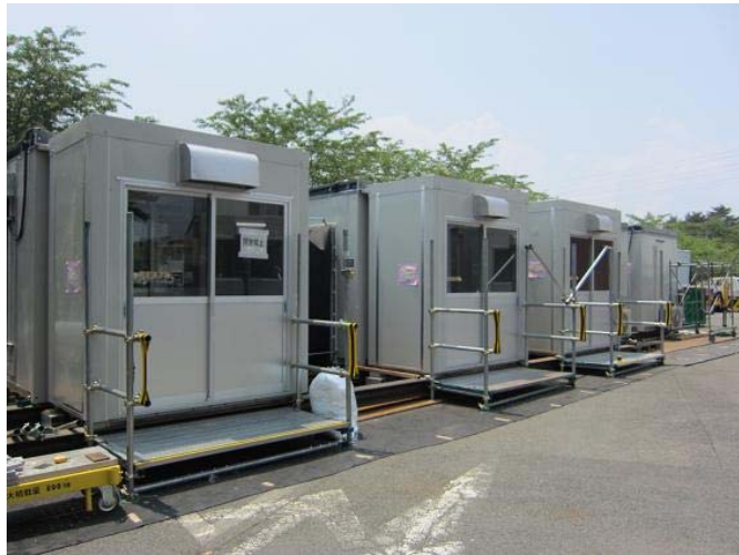
撮影日 : 平成23年6月10日 12時頃 場所 : 休憩所外観
