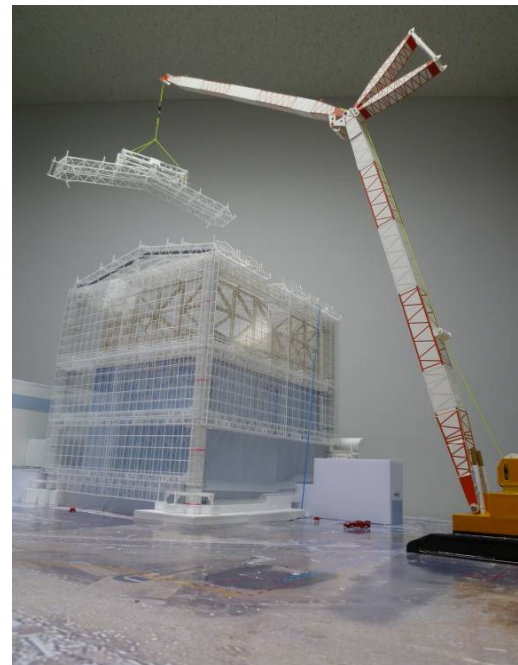
1号機原子炉建屋カバー施工模型
