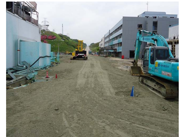
準備工事(クローラークレーン走行用道路整備)
