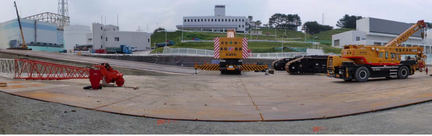
準備工事(物揚場整備 敷鉄板 敷設終了(6/11))
