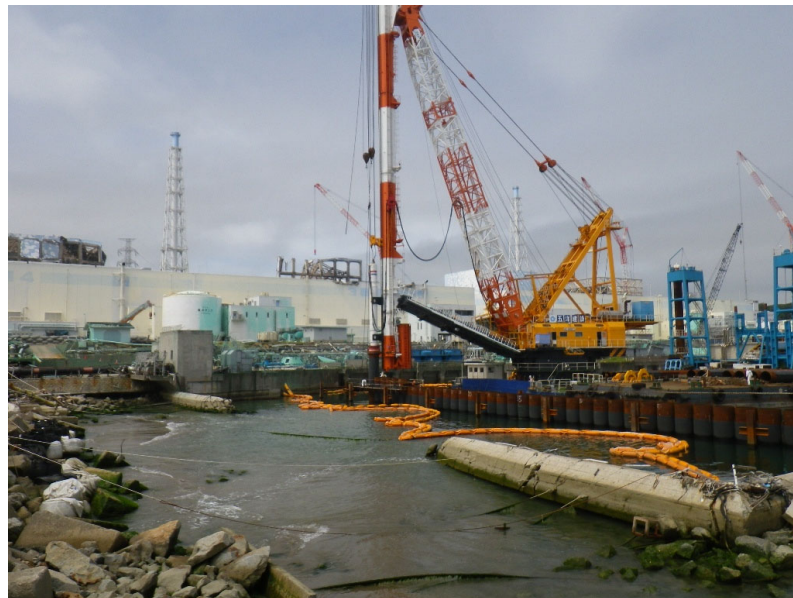
鋼管矢板打設置状況
