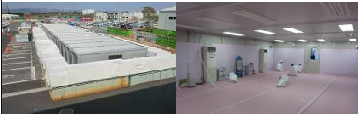
現場休憩施設外観(左)と内観(右)
