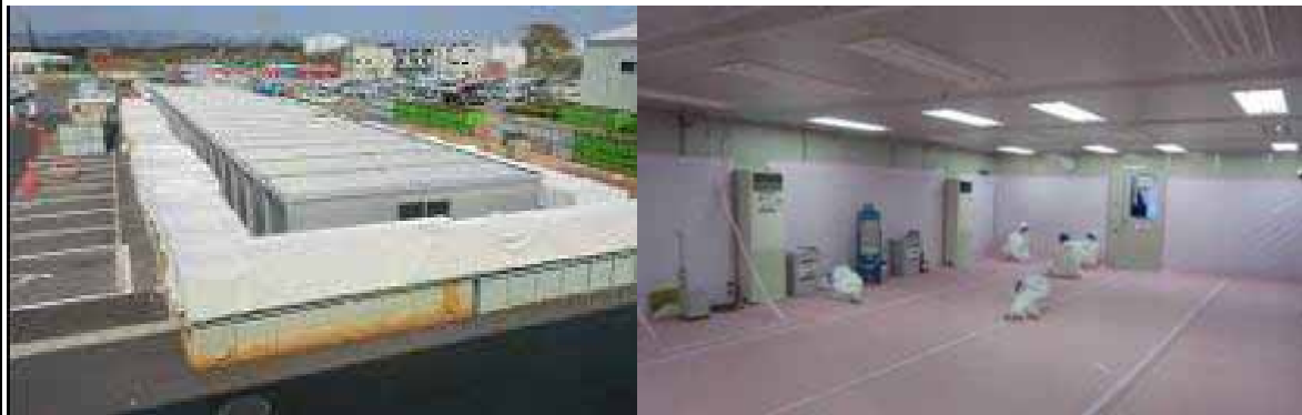
現場休憩施設外観(左)と内観(右)
