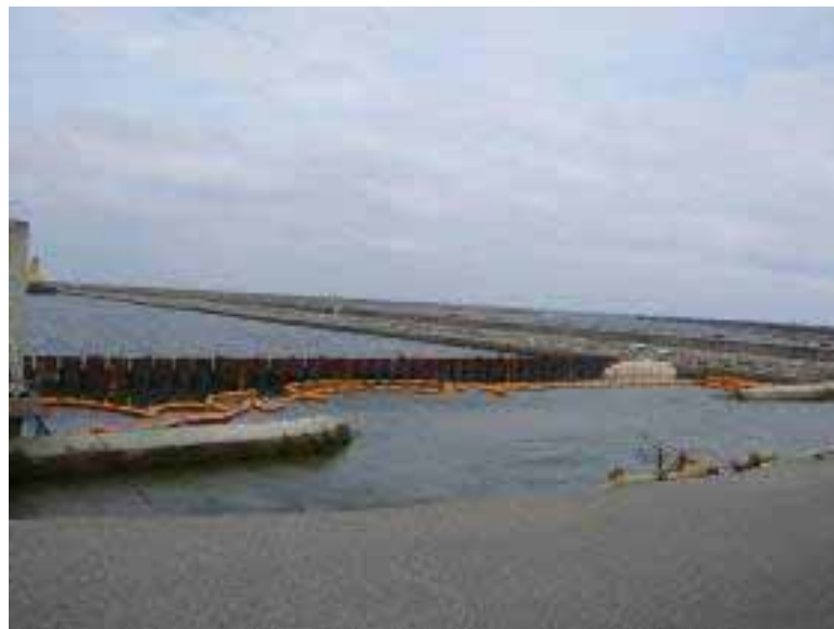
鋼管矢板設置状況
