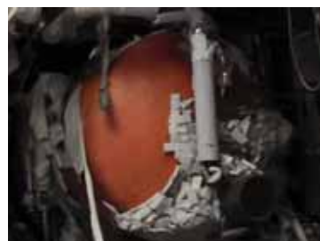
1号機 非常用復水器(B)
