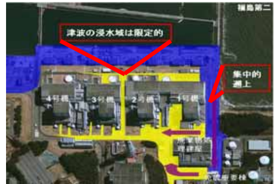
福島第二原子力発電所浸水域
