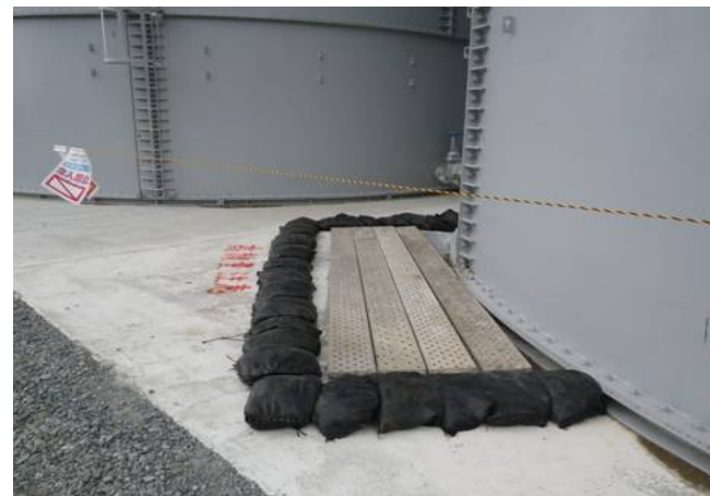
土のう設置状況
