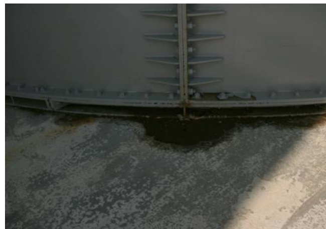
コンクリート基礎部
