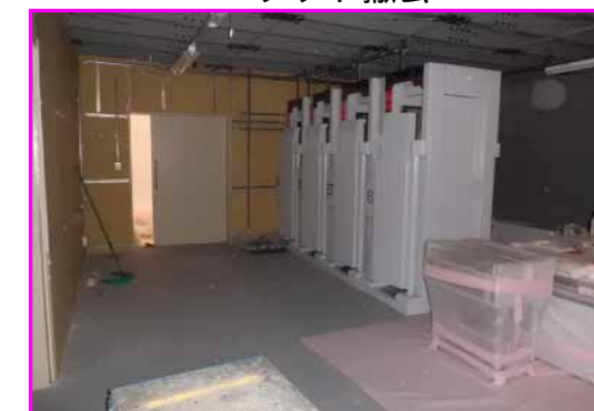
ゲートモニタ設置
