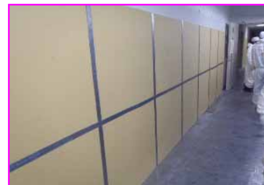
内壁への鉛ボード張り
