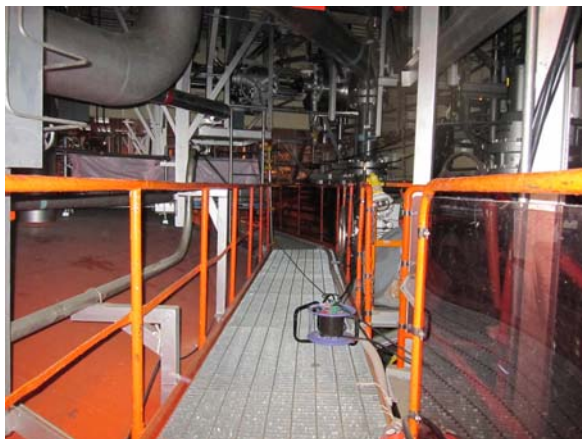
トーラス室の状況（5号機。照明あり）
