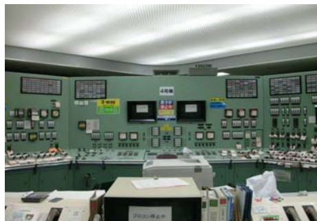
中央制御室の照明復旧(4号機)
