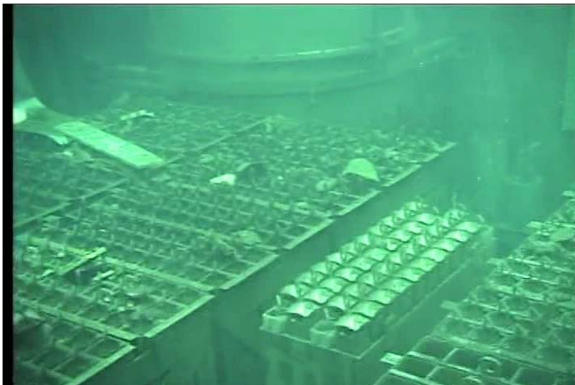
図13-5-6 4号機のSFP水中の状況（その1）
