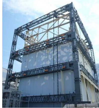
鉄骨建方完了(9/9)
