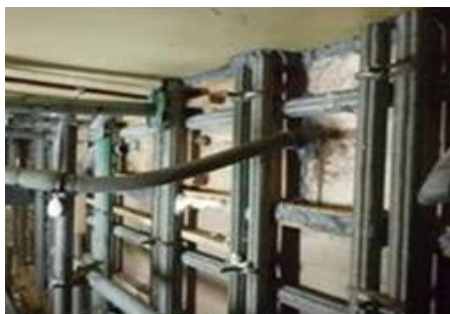
グラウト注入状況(7/30)
