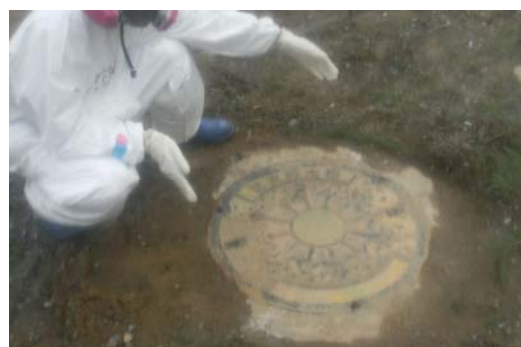
防火水槽の取水蓋
