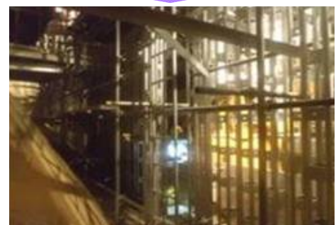
鋼製支柱設置状況(6/20)
