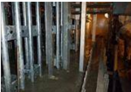
コンクリート打設状況(7/21)
