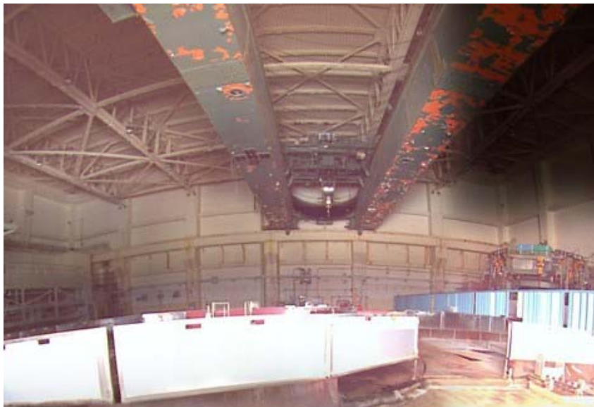
図5.2-2 9月17日撮影の5階原子炉直上部からの蒸気放出
