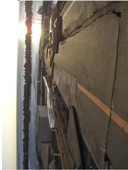
道路補強工事を実施した箇所であるが、補強していない道路面脇に割れ及び段差が発生。 3/17撮影
