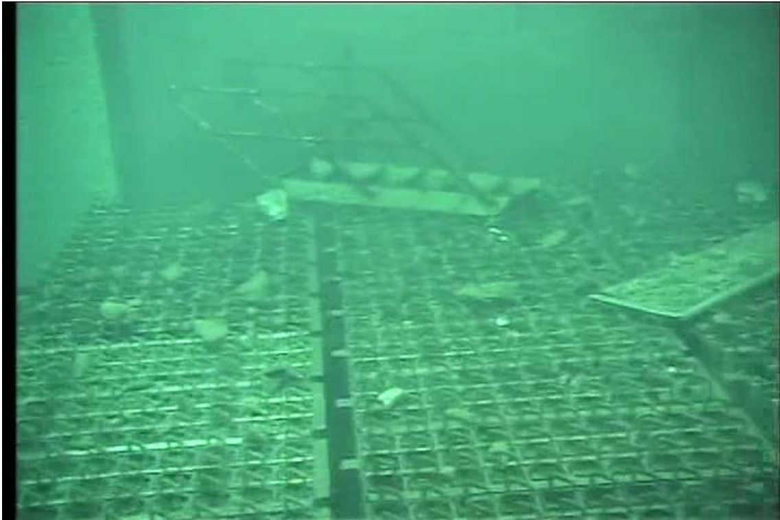
図13-5-7 4号機のSFP水中の状況(その2)
