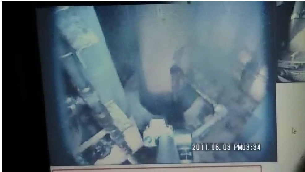
図5.1-2 6月3日撮影の1階床貫通部からの蒸気放出
