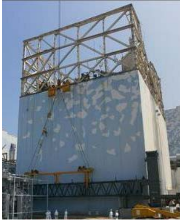
鉄骨建方開始(8/10)
