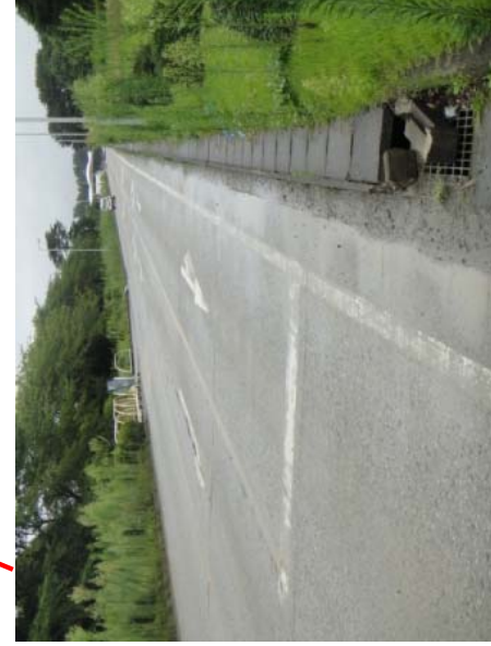
正門からの直線道路には特に異常なし。 8/26撮影
