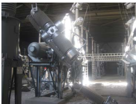
大熊線1L受電用しゃ断器（O-81）遮断部碍子全損
