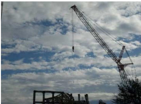
原子炉建屋上部の測定の様子
