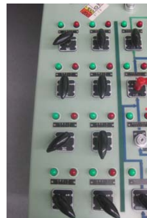
SRV 制御盤（後日撮影）
