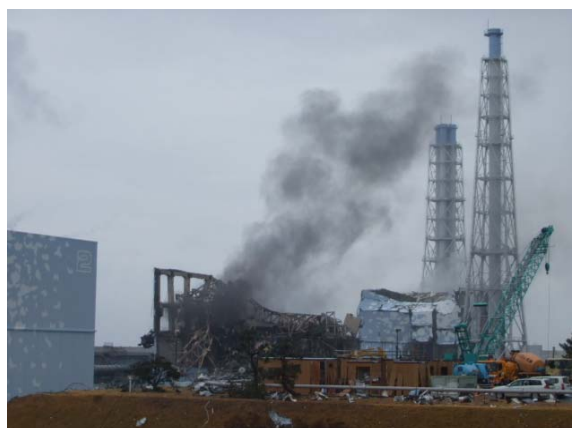
爆発後の3号機の外観 (撮影日: H23. 3. 21)
