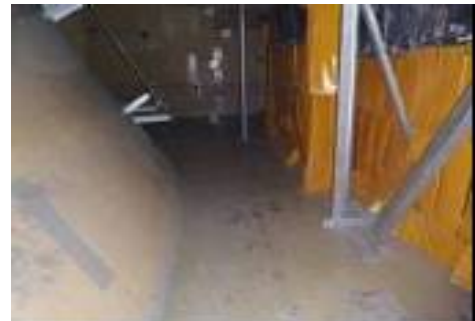
鋼製支柱設置前(5/31)
