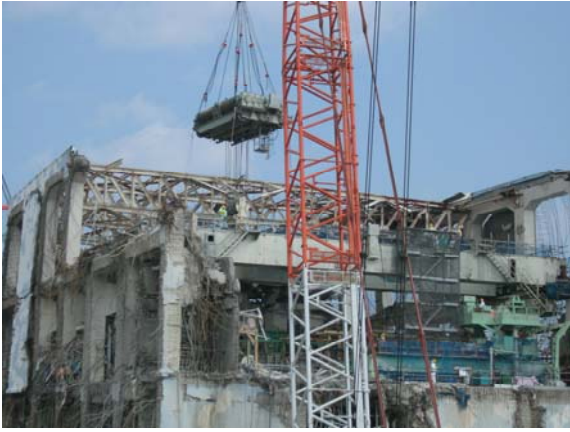
天井クレーントロリー撤去作業 (2/24)
