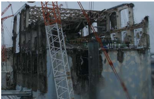
天井クレーンガーダー撤去作業 (3/5)
