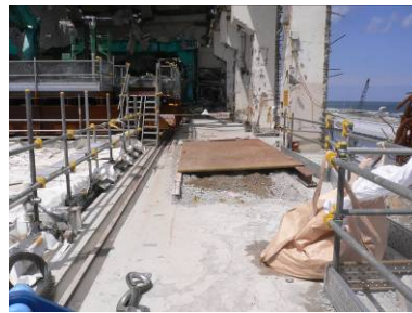
④床異常なし
