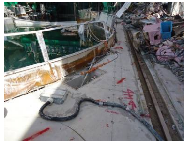
②シェル壁異常なし
