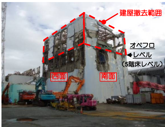
(a) 瓦礫撤去工事 着手前 撮影日：平成 23 年 9 月 22 日
