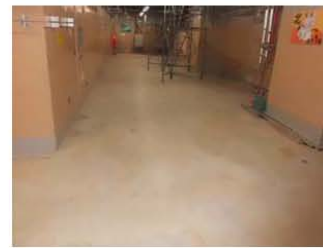
地下1階（撮影日：平成24年12月9日）
