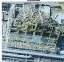
②東面 外壁
