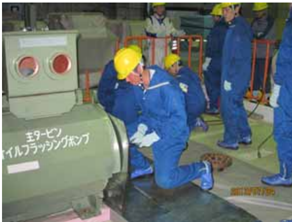
電動機取替え作業
