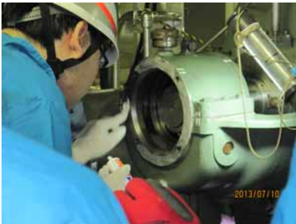
冷却ポンプ復旧作業
