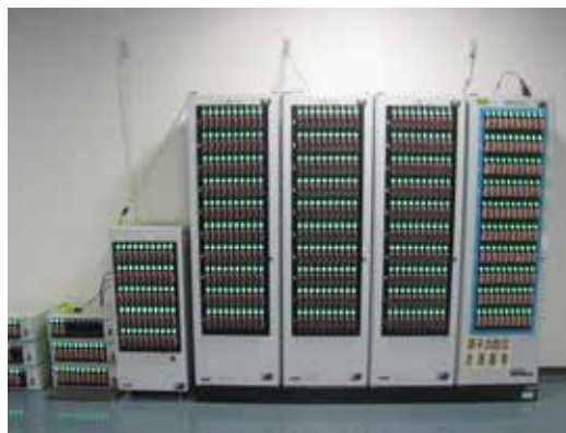
警報付個人線量計：120台→500台 (免震重要棟)
