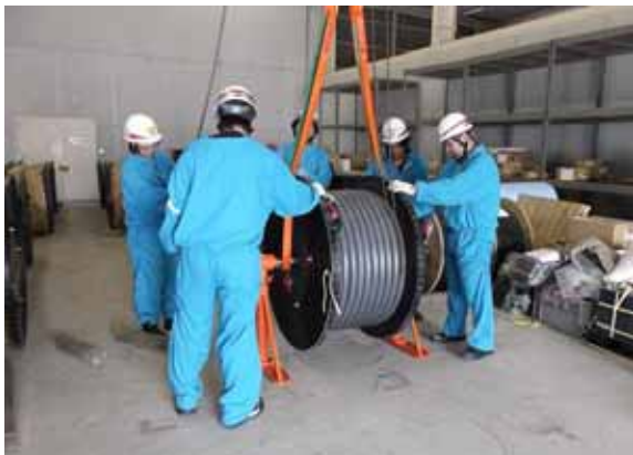
仮設ケーブル布設作業
