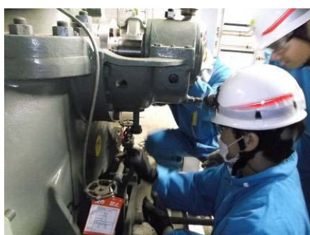
分解（付属配管取外し）
