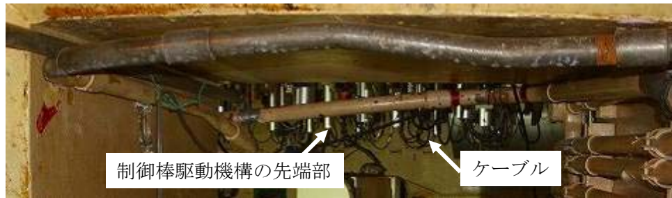
5号機ペDESTAL開口部
