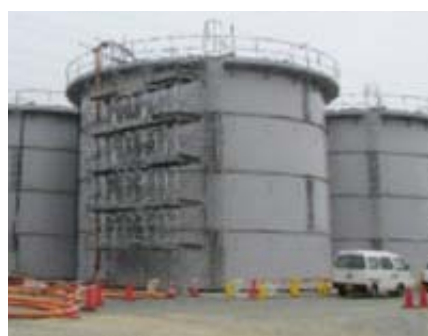
鋼製円筒型タンク (フランジ接合)
