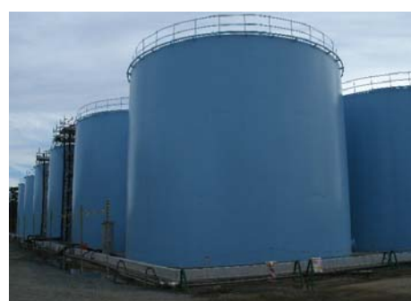
鋼製円筒型タンク (溶接)
