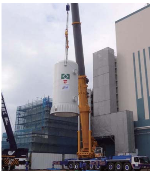
地上式フィルタベント工事状況
