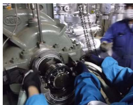
分解（軸受カバー・ケース取外し）
