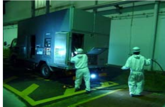
電源車からのケーブル引き出し
