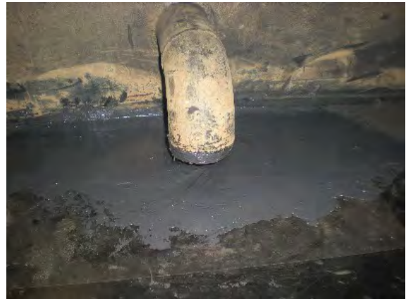
底板ドレン配管近傍
