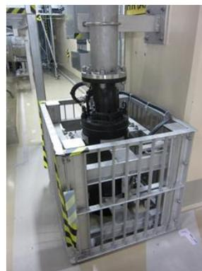
残留熱除去系ポンプ室常設排水ポンプ(7号機)
