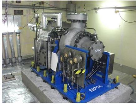
高压代替注水系ポンプの据付状況
