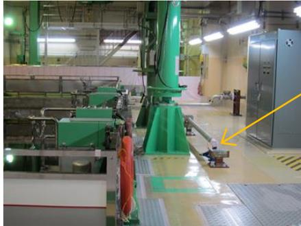
建屋外部から使用済燃料プールへのスプレー配管設置工事（7号機）
