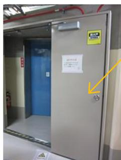
安全上重要機器が設置されている区域へ延焼を防止するための防火扉の設置
