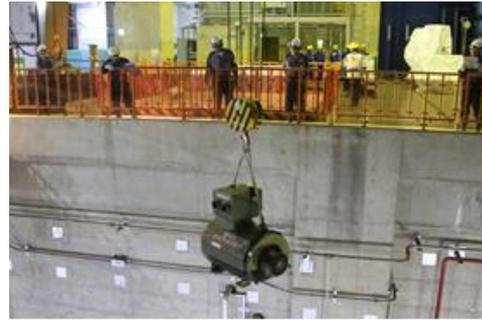
電動機交換作業（予備電動機の運搬）
