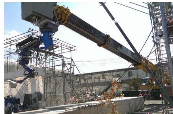
遠隔ロボットによるモックアップ状況
