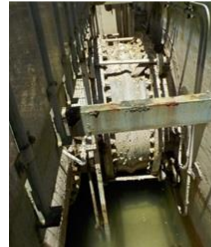
【6月27日移送終了後の配管貫通部（海側）】
