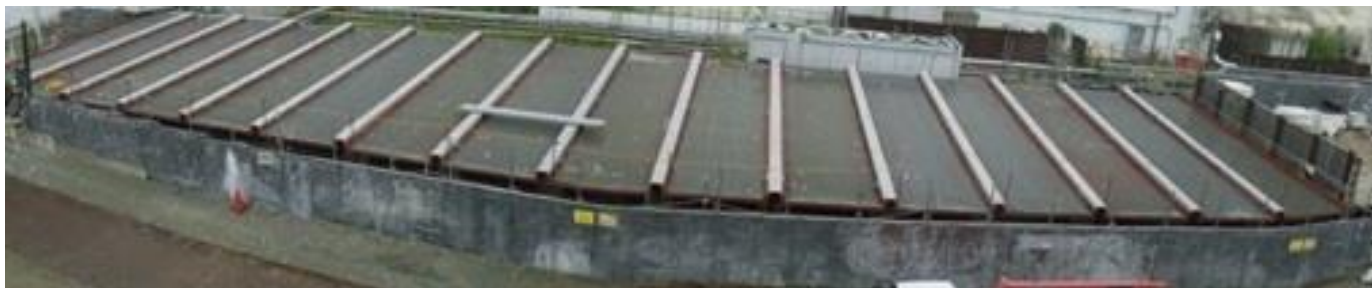
【逆洗弁ピット上部の屋根設置状況】
