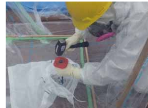
ガレキ(コンクリート)の粗粉碎
