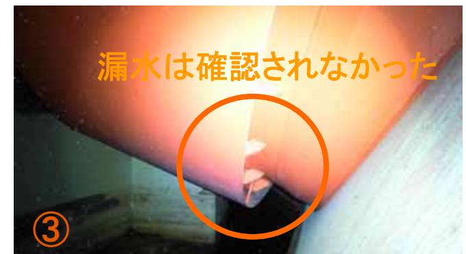
ベント管ベローズカバー下部
