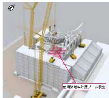
図4：3号機ガレキ撤去イメージ
