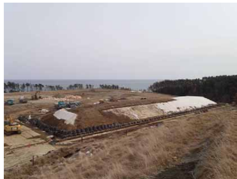
1 槽目の状況（2/12撮影）
