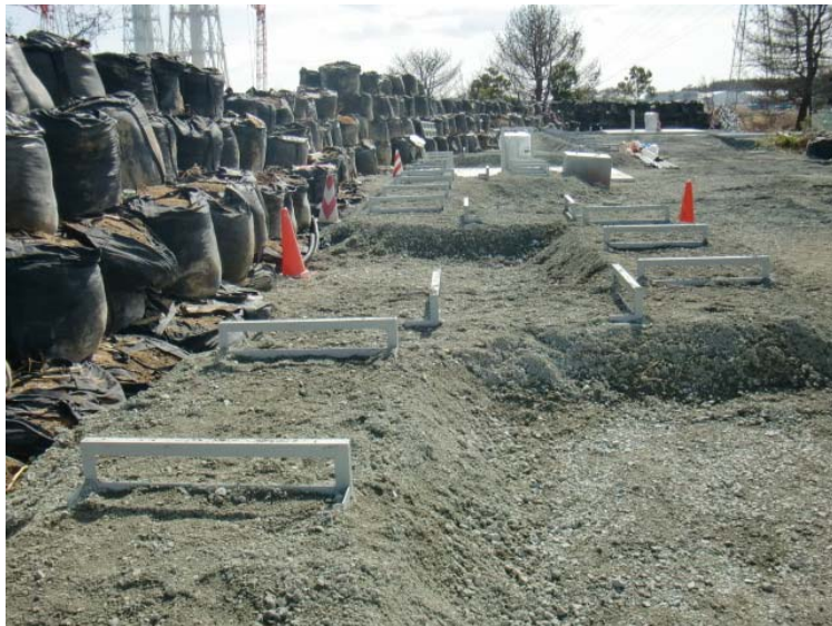
A系統配管基礎設置状況
