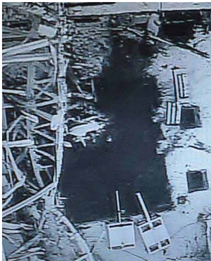
使用済燃料貯蔵プール（撤去後）
