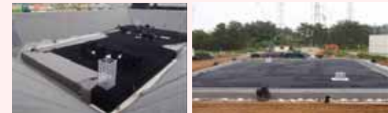
地下貯水槽設置状況
