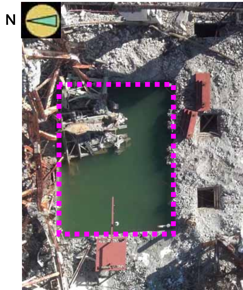
写真2：使用済燃料貯蔵プール周辺がれき撤去後 (2013年2月9日撮影)
