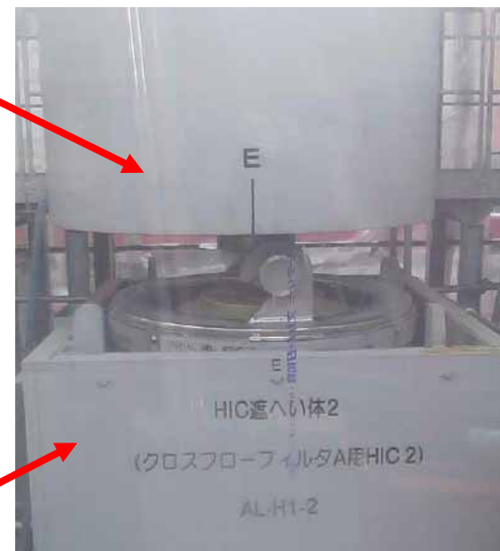
HIC遮へい体からの吊上げ
