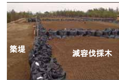
図8：伐採木一時保管槽の設置状況(2/19撮影)
