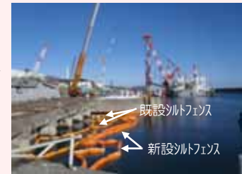
シルトフェンス交換の様子
