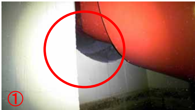
ベント管スリーブ端部
