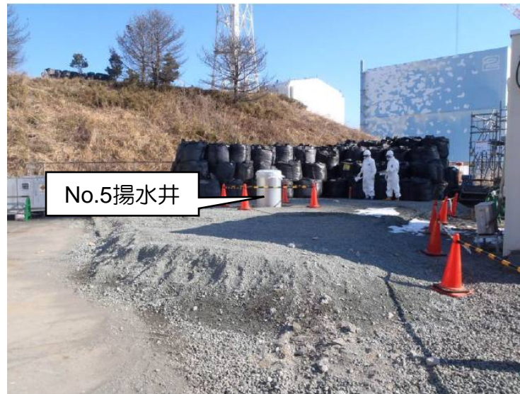
No.5揚水井（B系統）掘削完了状況
