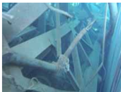
画像：燃料交換機の歩廊部の状況
