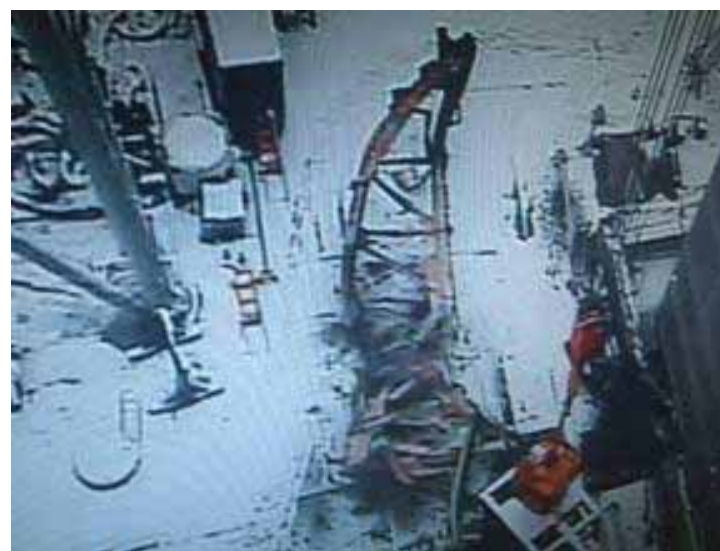
鉄骨トラスがれき（撤去後）
