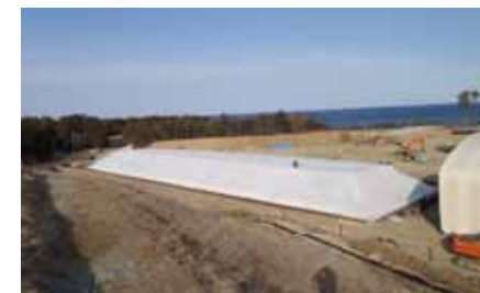
図7：2槽目の設置状況(2/26撮影)
