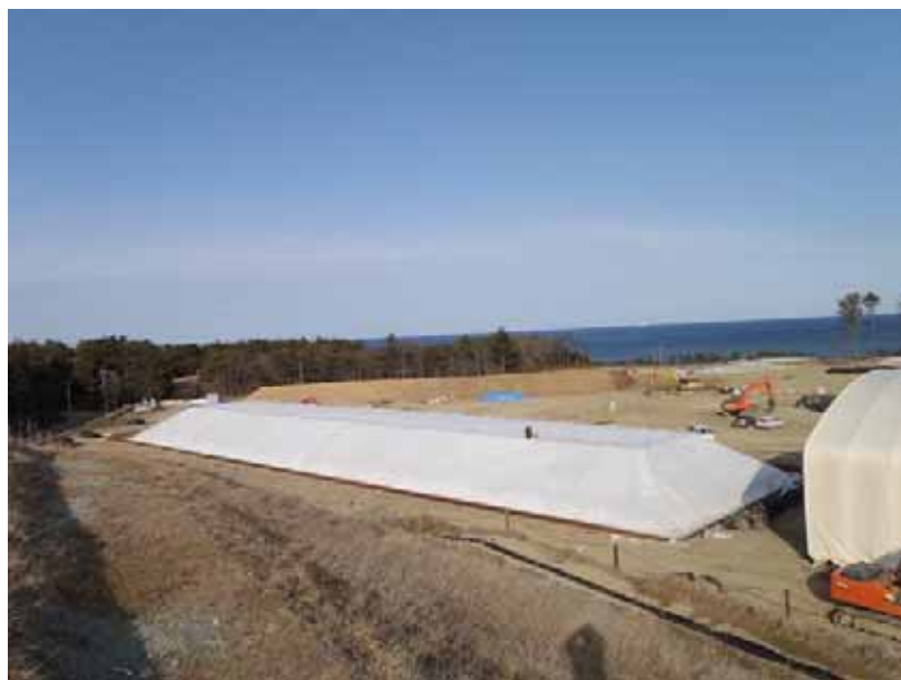
2 槽目の状況（2/26撮影）
