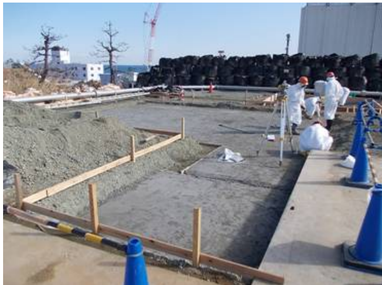
A系統バッファタンク設置状況
