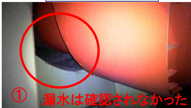
ベント管スリーブ端部
