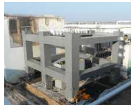
図3：鉄骨建方2節目完了(2/28撮影)
