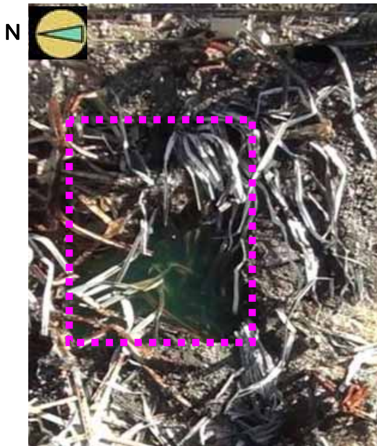
写真1：使用済燃料貯蔵プール周辺がれき撤去前 (2011年11月12日撮影)
