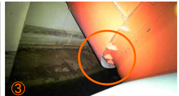
ベント管ベローズカバー下部
