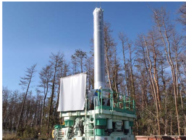
No.1 O揚水井（B系統）内管設置状況
