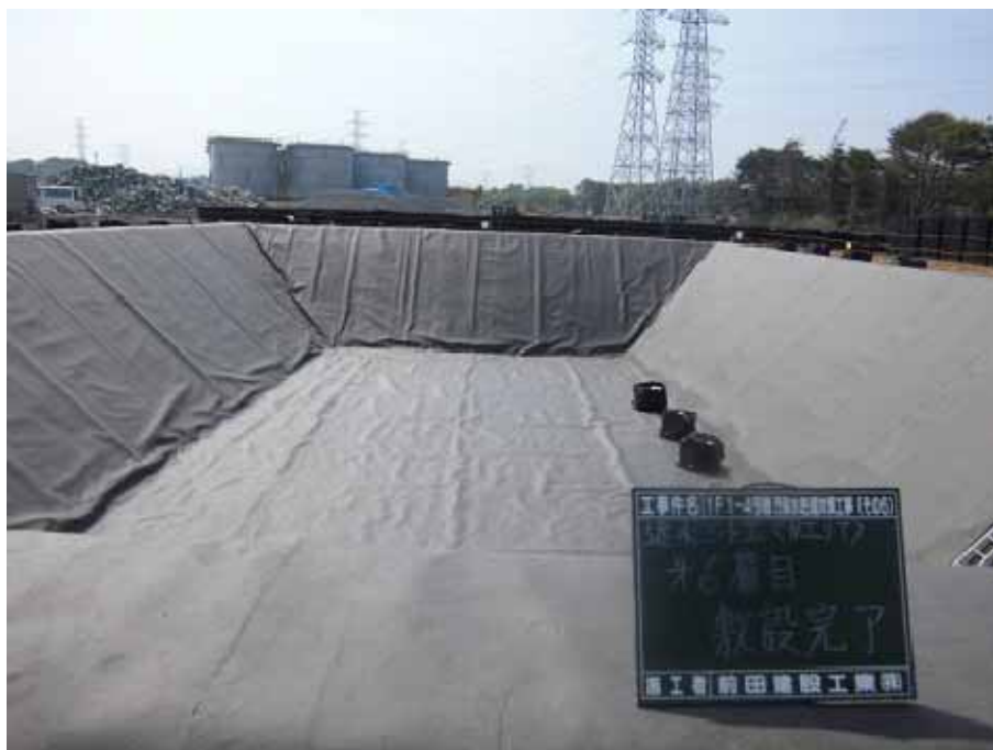
【シート敷設完了】
