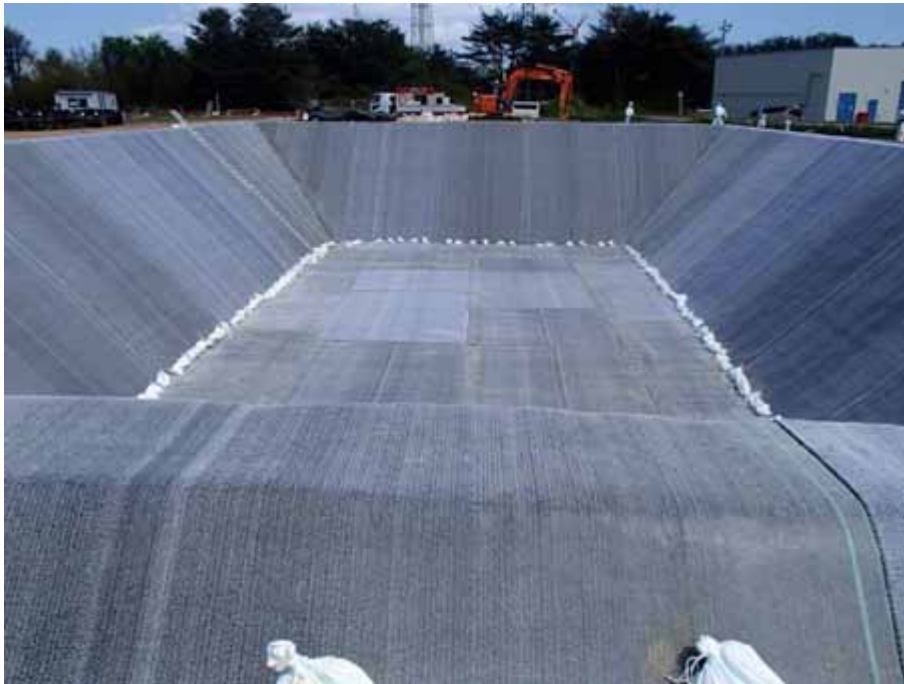
【ベントナイトシート敷設完了】
