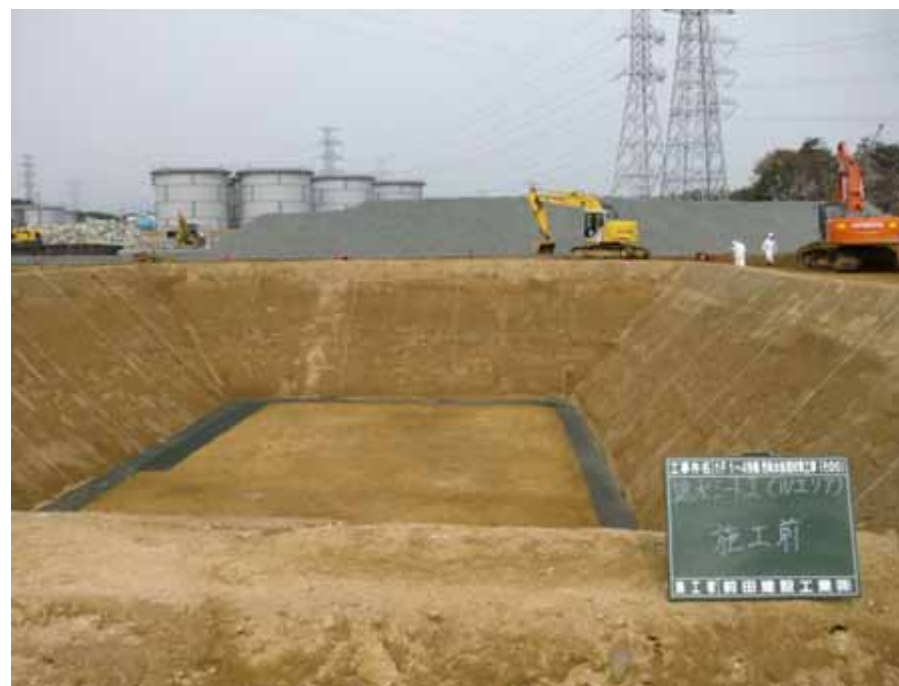
【掘削・地盤改良完了】
