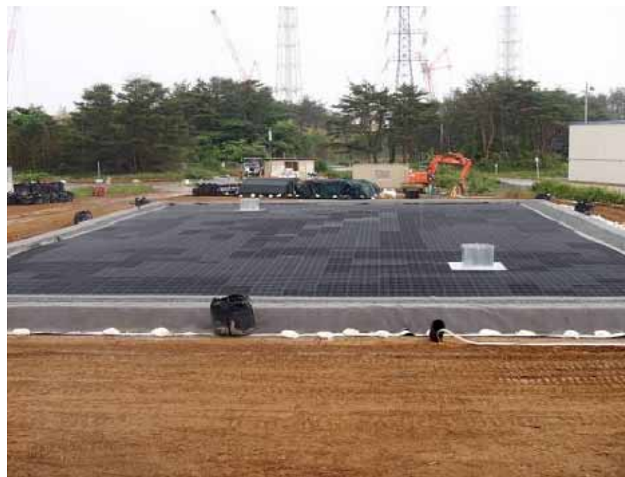
【貯水材組立完了】
