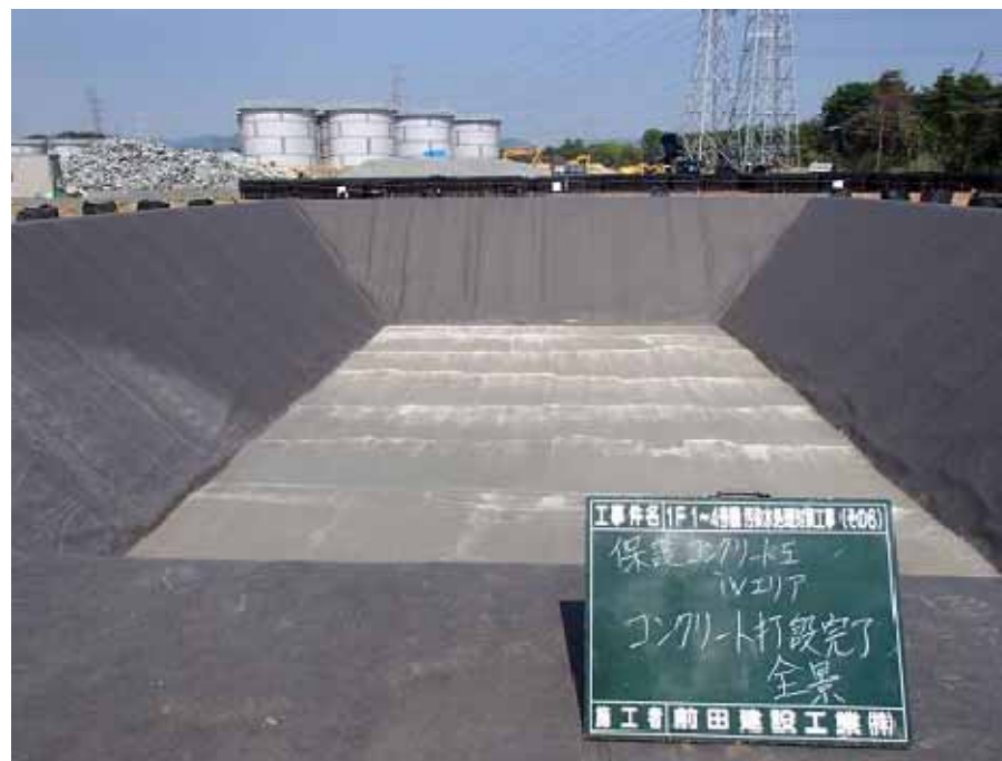
【保護コンクリート打設完了】
