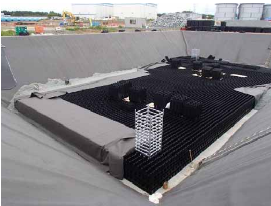
【貯水材組立状況】
