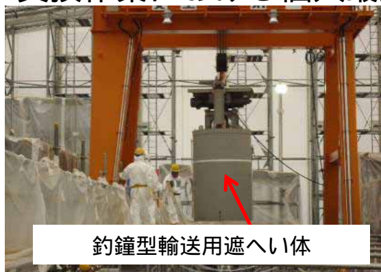
多核種除去設備設置エリア
