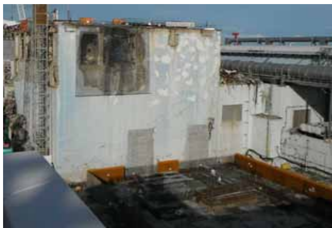
鉄骨建方 着工前（平成24年12月18日）
