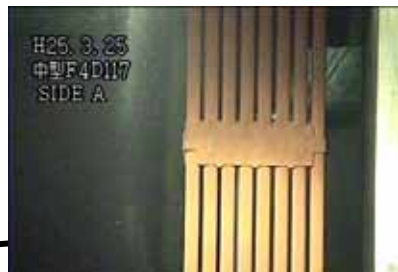
スペーサ、被覆管 変形・損傷無し
