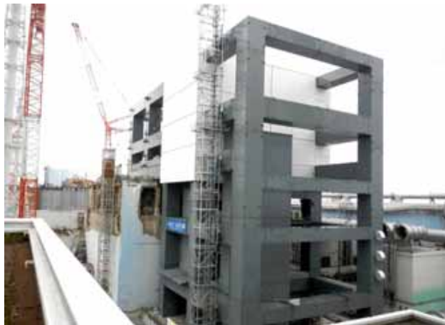
鉄骨建方の完了（平成25年5月29日）
