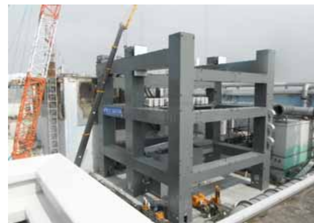
第3節部分の完了（平成25年3月13日）
