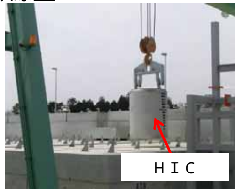
一時保管施設エリア
