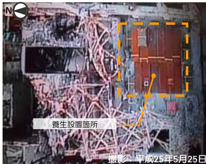
オペレーティングフロア全景（養生更新後）
