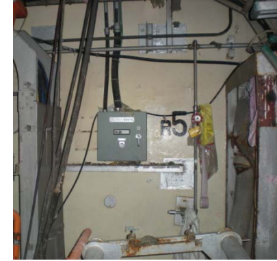
④ 西面（内壁）
