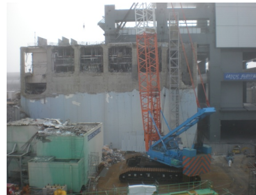
⑤ 西面（外壁）
