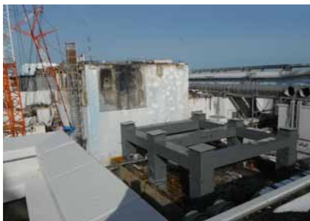
第1節部分の完了（平成25年1月14日）
