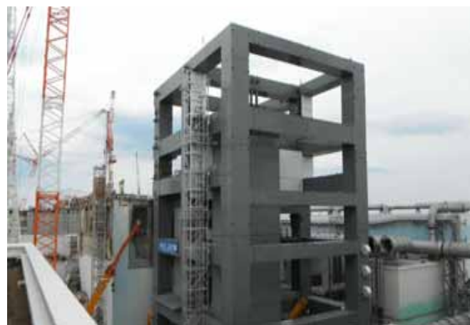
原子炉建屋上部を除く鉄骨建方部分の完了 （平成25年4月10日）
