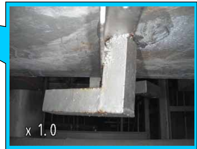
撮影箇所⑤壁面側上部隙間(床上4.3m)
