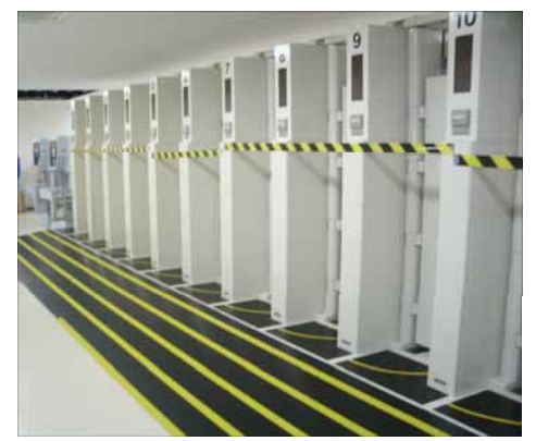
<入退域管理棟内部>
