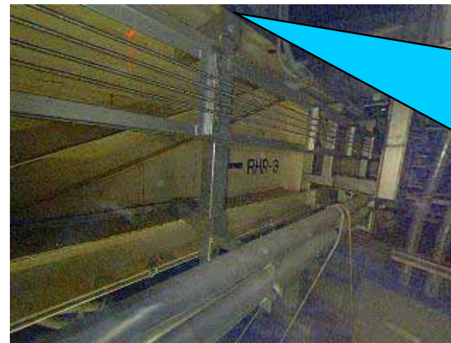
撮影箇所⑤壁面側(床上3.5m)
