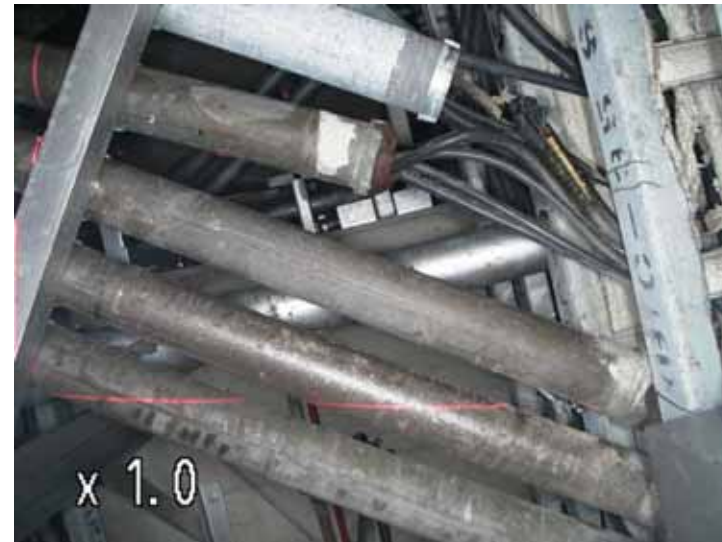
撮影箇所①天井状況
