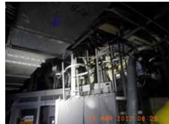
R/B1階上部の状況 (2号機の例)
