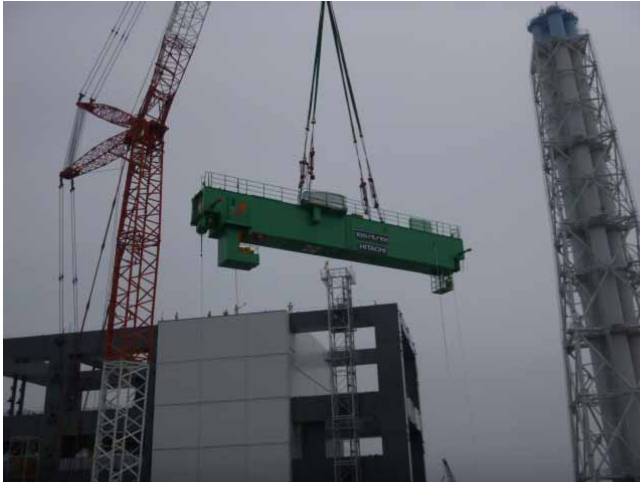
天井クレーン部材吊り上げ
