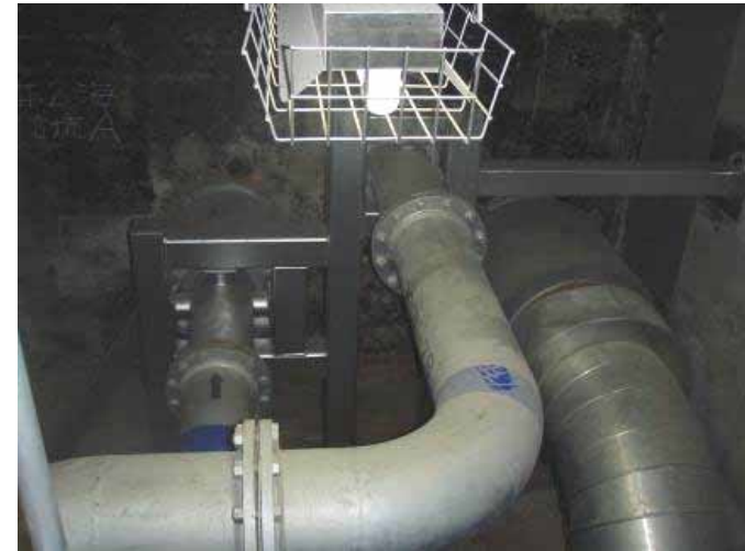
建屋接続部（奥：配管貫通部）
