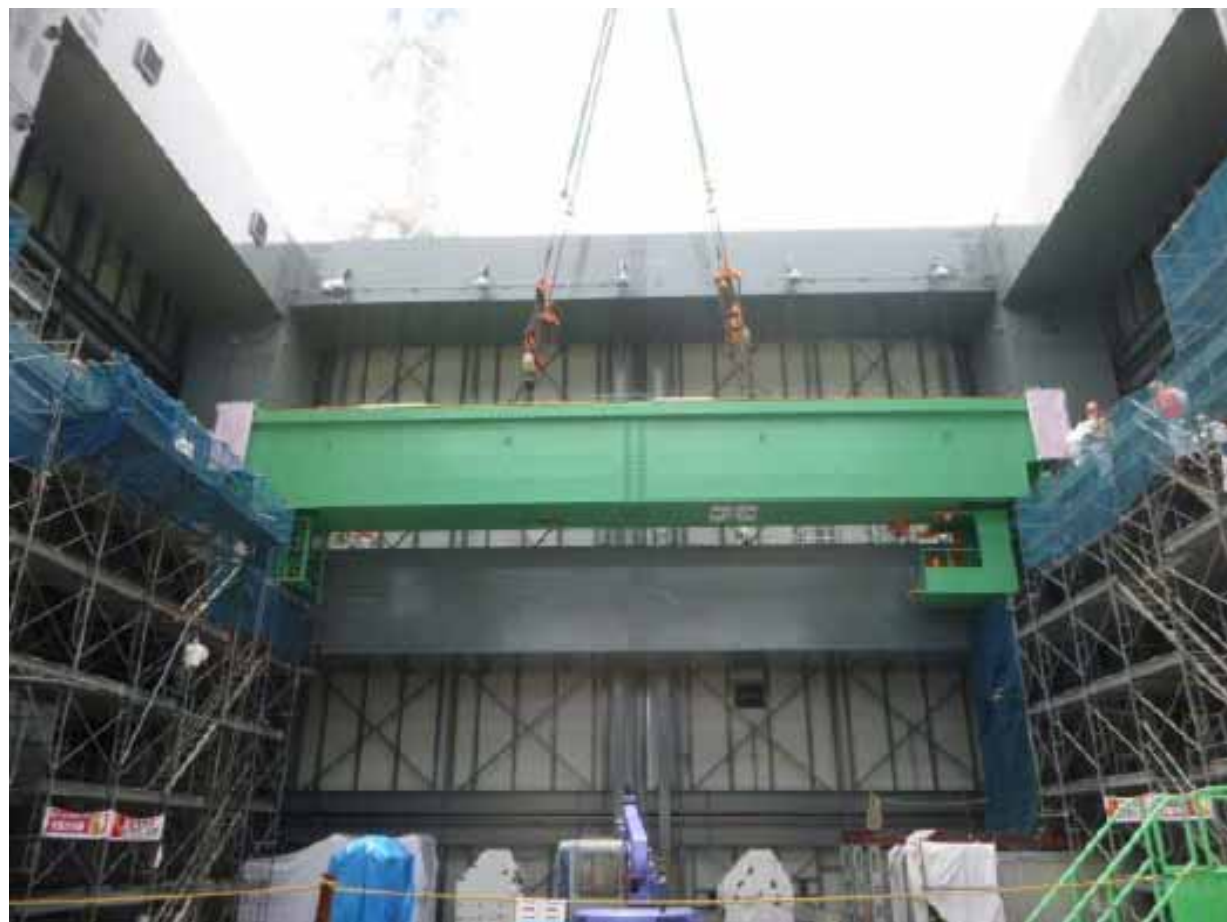
天井クレーン部材上架
