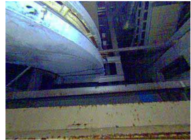
撮影箇所④壁面側上部(床上4.0m)
