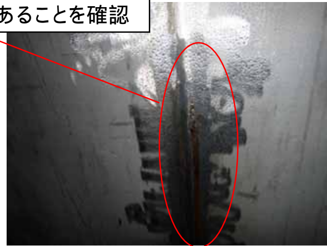
タンク下部状況(拡大)
