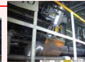
格納容器側状況
