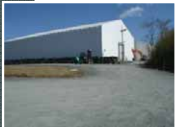
瓦礫保管テント
