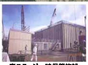
廃スラッジ一時保管施設
