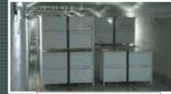
固体廃棄物貯蔵庫
