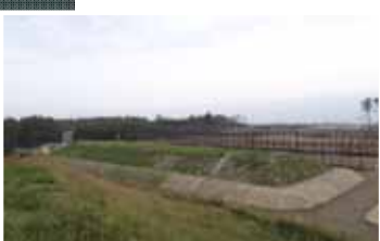
覆土式一時保管施設
