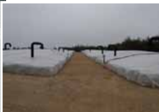
伐採木一時保管槽
