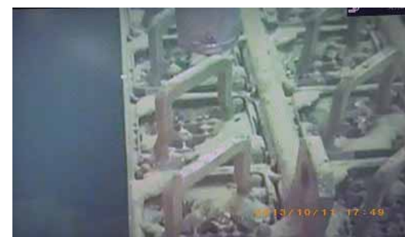
ガレキ吸引作業前
