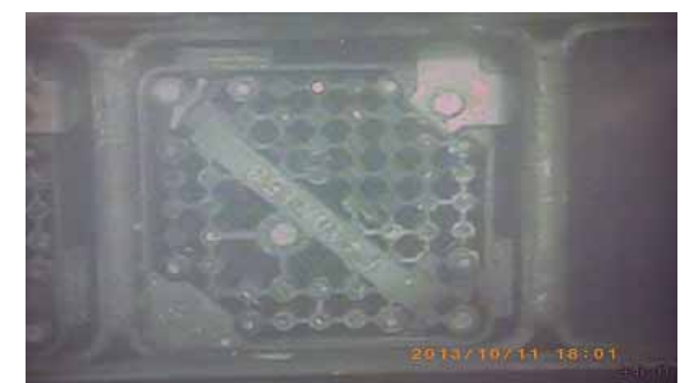
ガレキ吸引作業後
