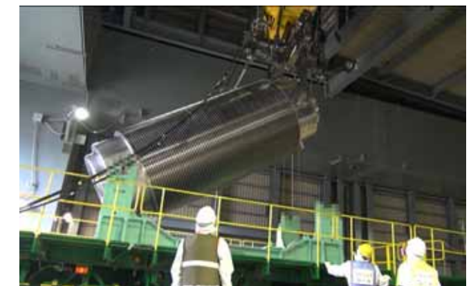
構内用輸送容器のトレーラへの積み込み（11/21）
