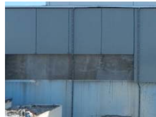
⑤ 西面（外壁）
