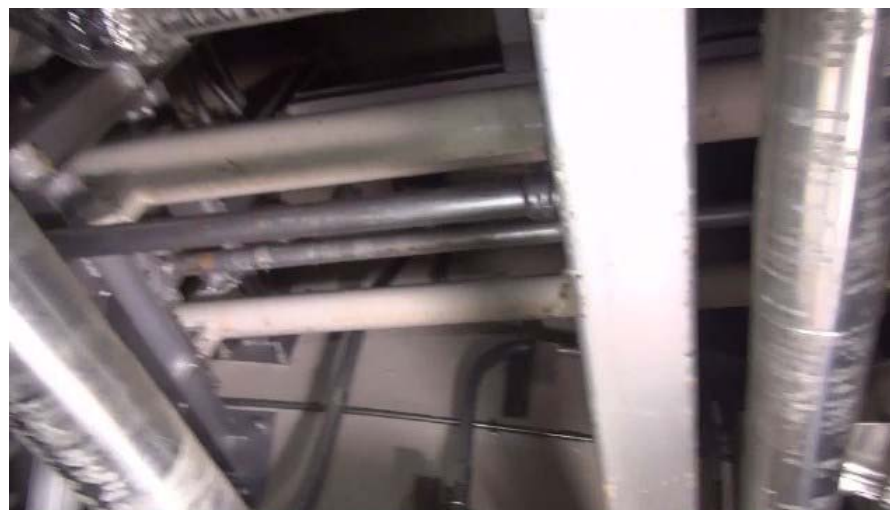
写真 : 3階 シェル壁(2)
