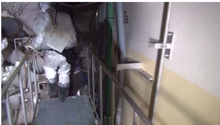
写真：4階 使用済燃料プール壁
