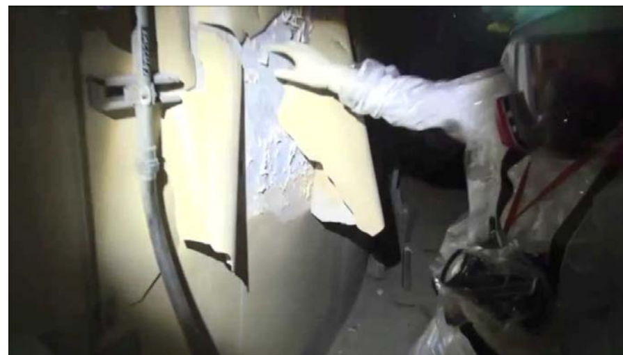
写真：4階 シェル壁(2)
