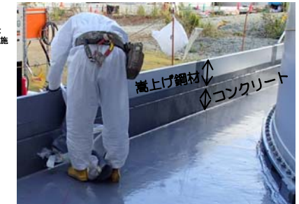
鋼製板による堰の嵩上げ実施状況
