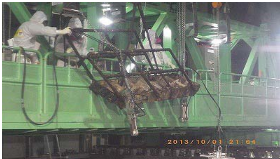
使用済燃料プール内ガレキ(作業台車用階段)
