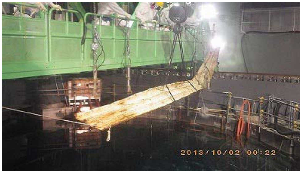
使用済燃料プール内ガレキ(デッキプレート)
