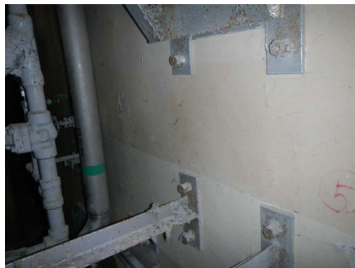
① 西面（内壁）
