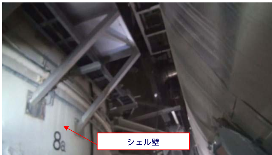
写真：4階 シェル壁(1)
