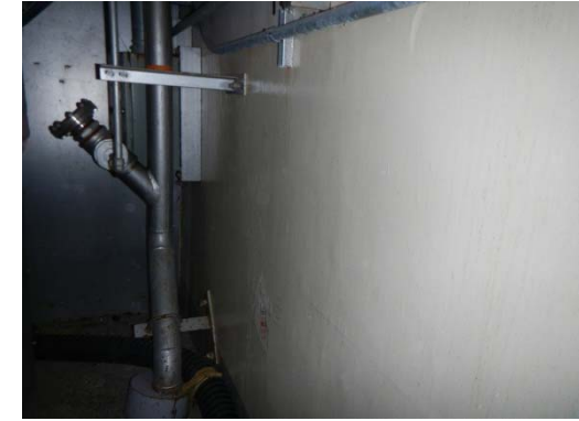
④ 西面（内壁）
