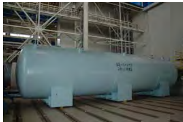
廃スラッジ一時保管施設貯槽 *2
