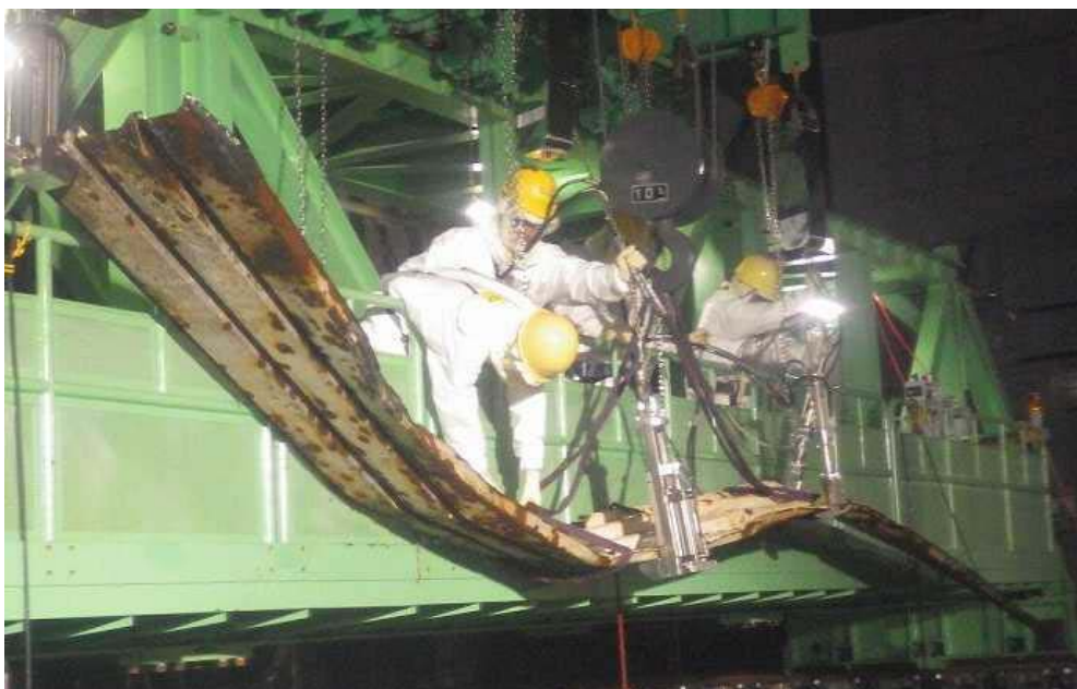
原子炉ウェル内ガレキ(デッキプレート)
