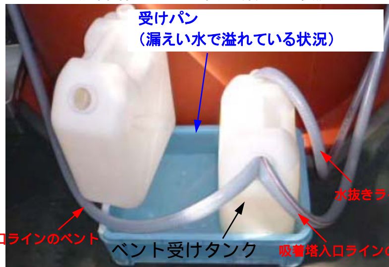
ベント受けタンク (吸着塔の水張り時使用)
