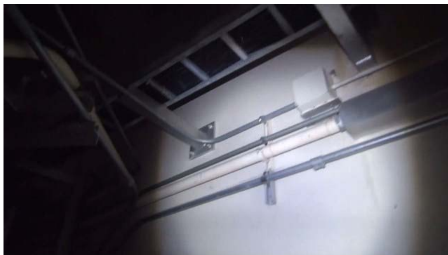
写真：4階 シェル壁 (3)
