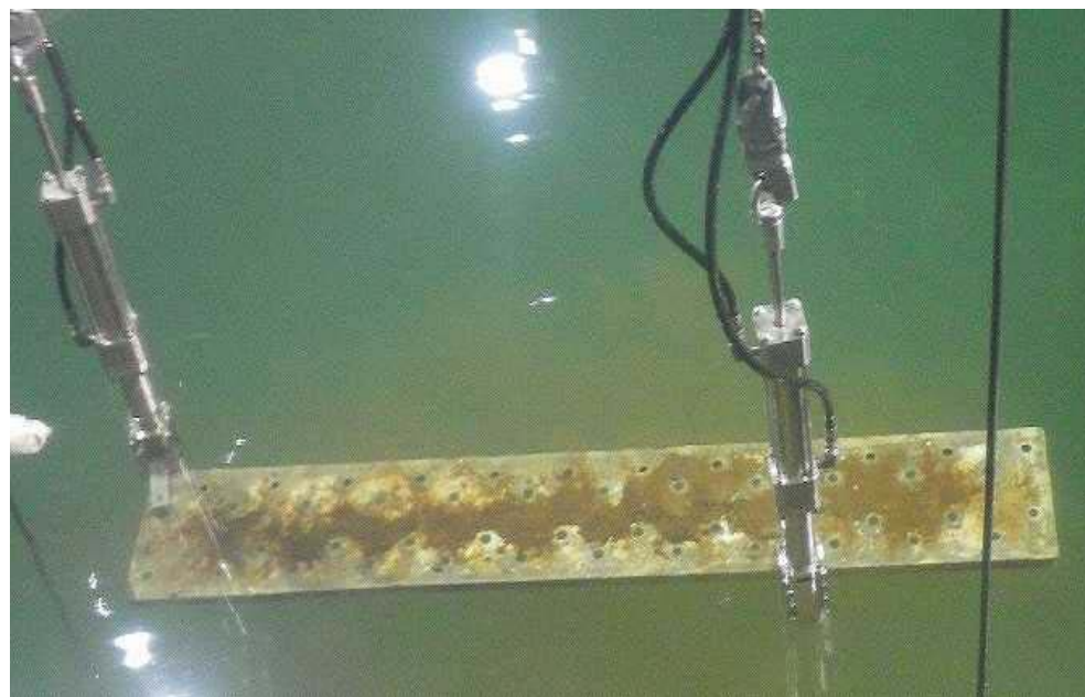
使用済燃料プール内ガレキ(足場板)
