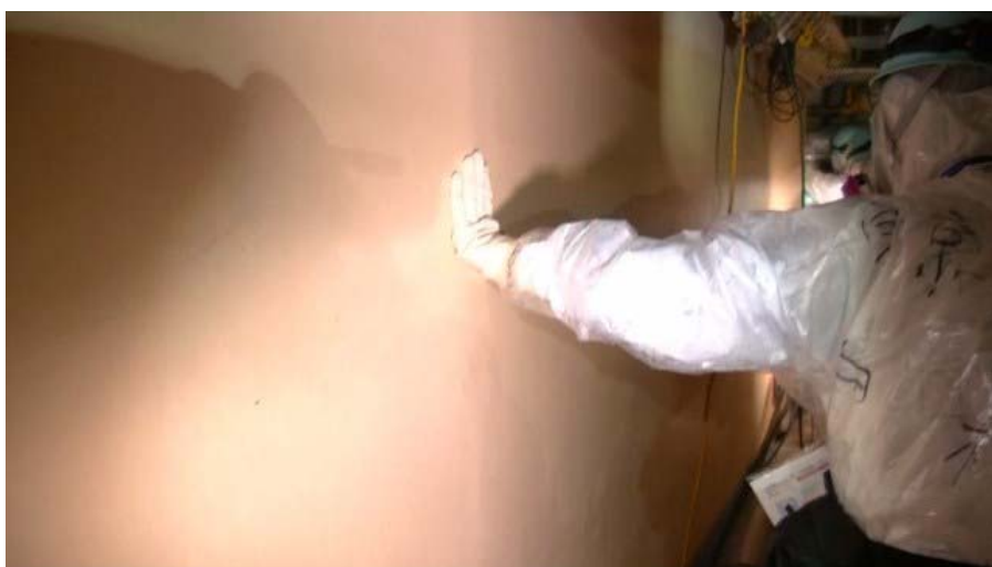
写真：3階 使用済燃料プール壁
