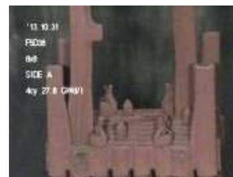
図3 上部タイププレート締結部の外観
