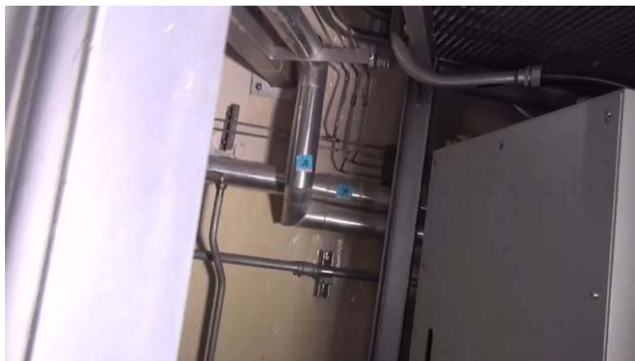
写真 : 3階 シェル壁(1)
