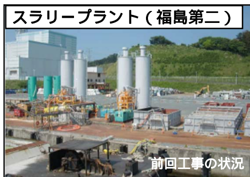
福島第二にスラリープラントを設置した海上施工システム (被覆材 A の場合)
