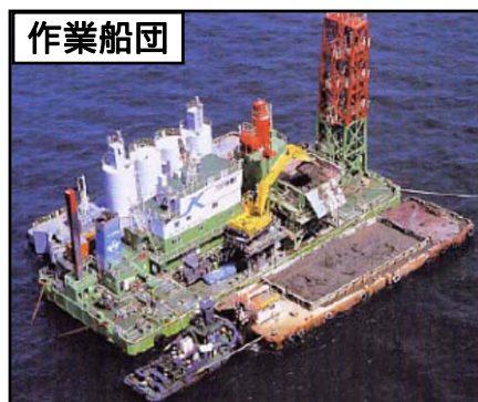
福島第二にスラリープラントを設置した海上施工システム (被覆材 A の場合)
