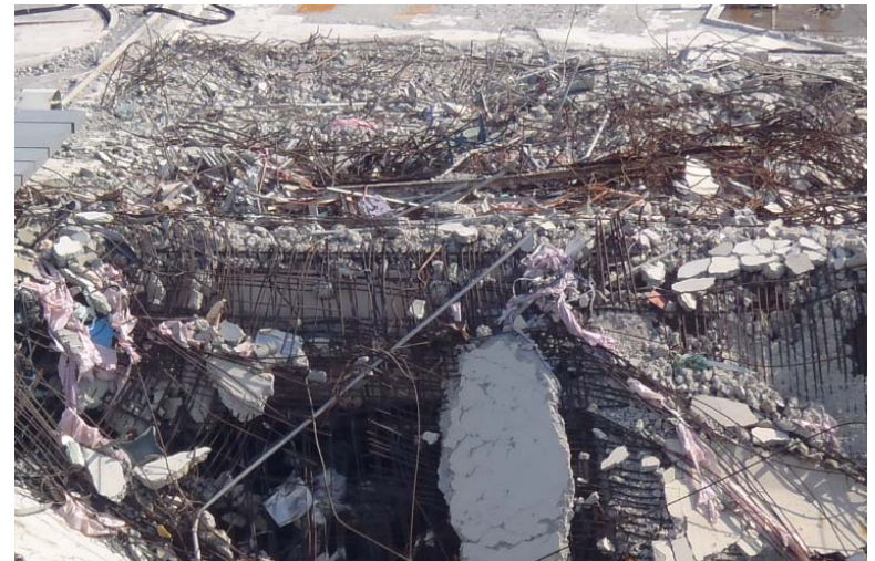
G工区 (北西崩落部) 拡大写真
