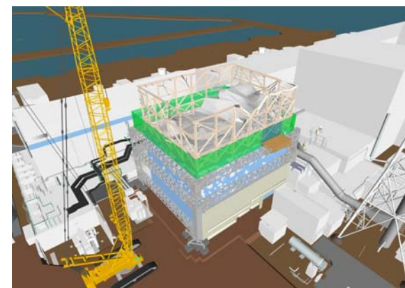
⑥建屋カバー解体完了 ⇒その後、ガレキ撤去作業に移行
