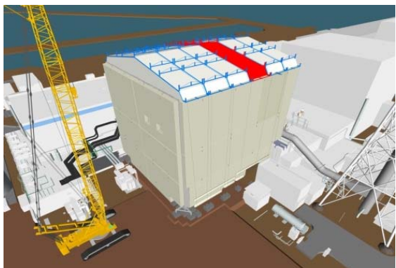
①屋根パネル解体開始
