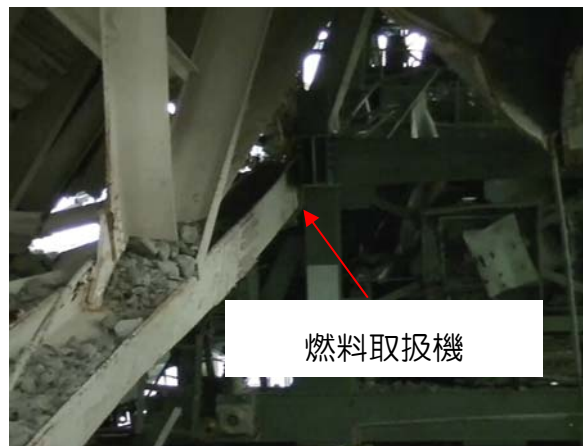
撮影H24.10月(オペフロ バルーン調査)
