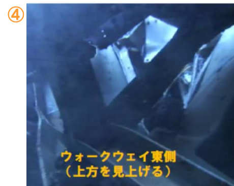
東側ウォークウェイは瓦礫が多く未確認状態
