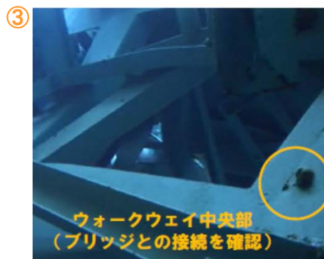
ブリッジとウォークウェイ中央は接続した状態
