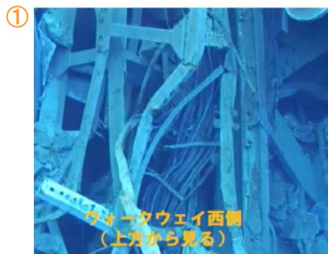
激しく損傷した西側ウォークウェイ
