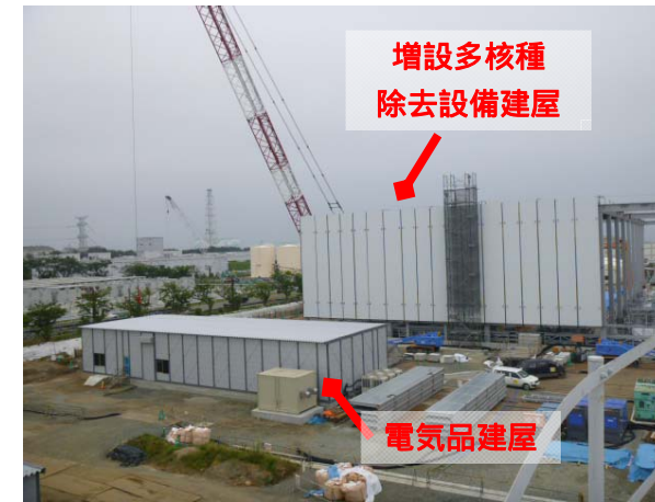
図3：増設多核種除去設備 全景
