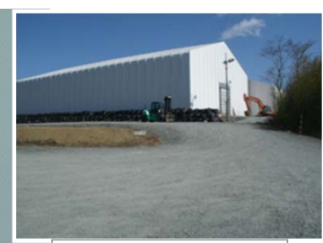
瓦礫保管テント
