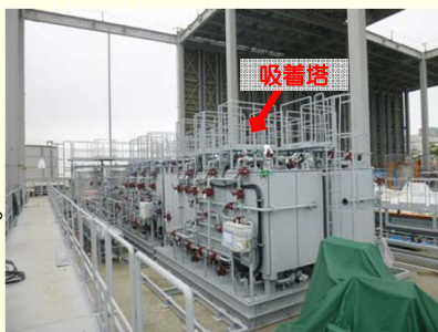
< 増設多核種除去設備 設置状況 >
