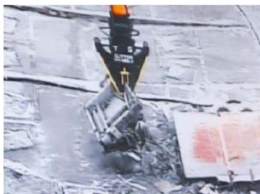
(5) オペフロより走行用補助ホイスト撤去
