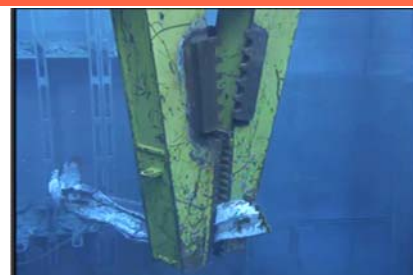
<使用済燃料プール内ガレキ撤去作業状況>
