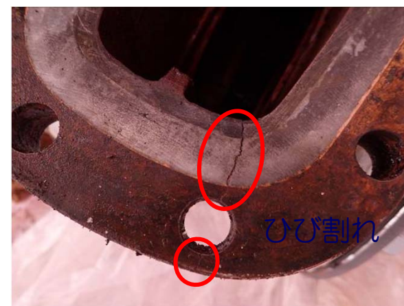
ガスケット取り外し後
