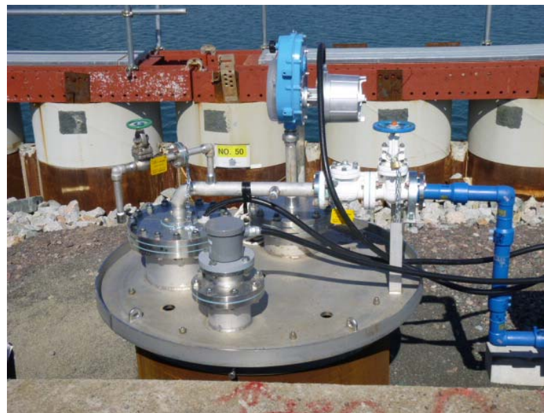
地下水ドレンポンド（A）
