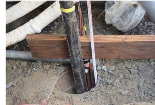
充填孔付近の様子
