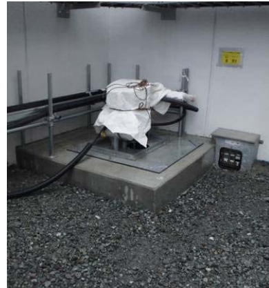
サブドレンピット
