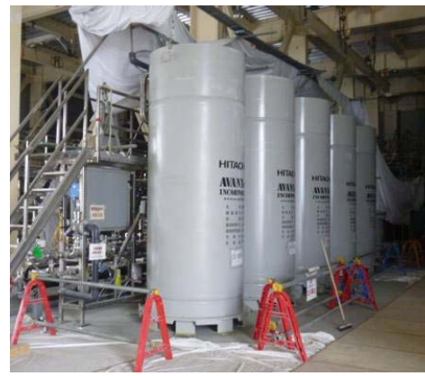
浄化設備 (吸着塔)
