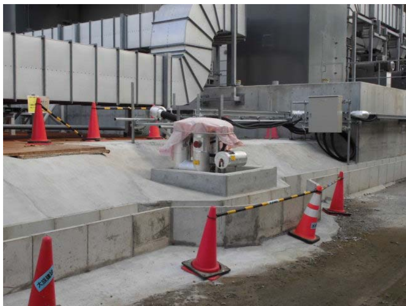
N15サブドレンピット
