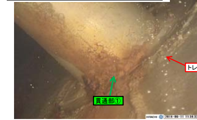
〈調査カメラ映像〉貫通部①トレーサ投入による流れの確認
