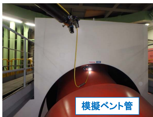
D/Wーベント管接合部調査装置工場試験
