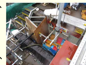
<充填孔付近の様子>
