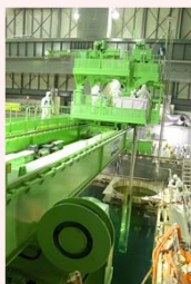
燃料取り出し状況
