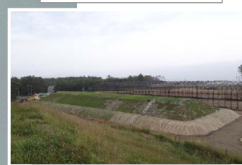
覆土式一時保管施設
