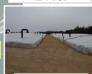
伐採木一時保管槽
