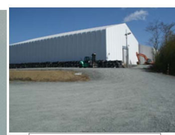
瓦礫保管テント
