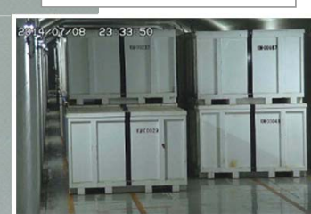
固体廃棄物貯蔵庫
