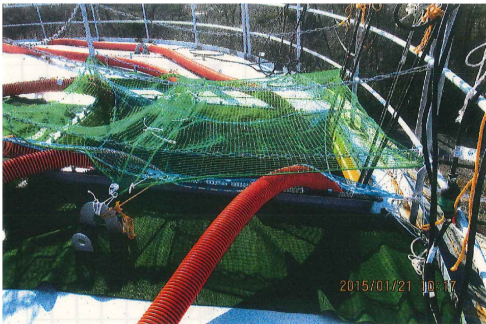
ハッチ開口部転落防止措置
