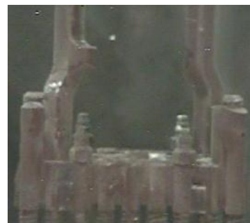
図3 4号機使用済燃料上部タイブレート締結部の外観
