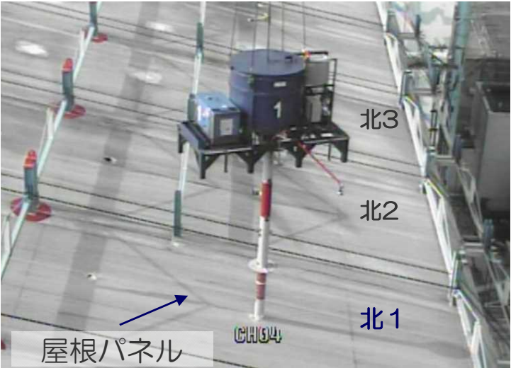
北1 屋根パネル飛散防止剤散布状況
