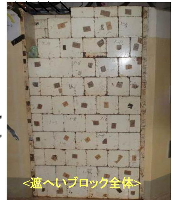
現場調査の結果、遮へい体は①～④の形状のコンクリートブロックで構成され、最大重量は約36kg(形状①)と想定
