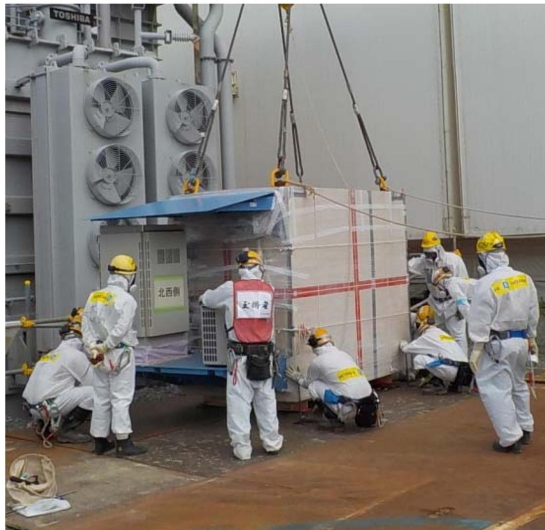
写真2 測定装置1(北西側→北側)の移動作業
