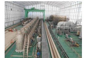
(高性能多核種除去設備)
