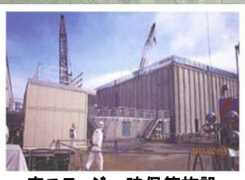
廃スラッジ一時保管施設
