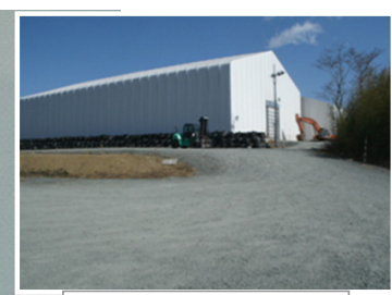
瓦礫保管テント
