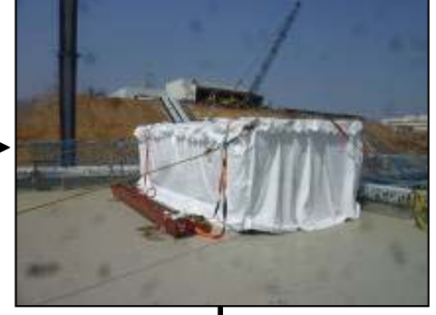
【写真④】仮設テント設置完了 (3月31日)
