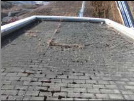
【写真①】作業前
