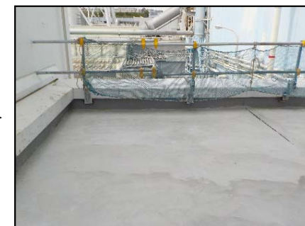
【写真⑤】押さえモルタル打設 (5月30日)
