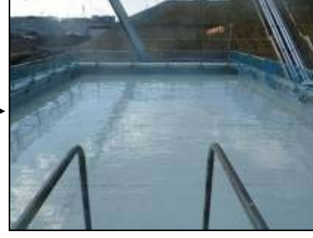
【写真③】ウレタン防水完了 (3月14日)
