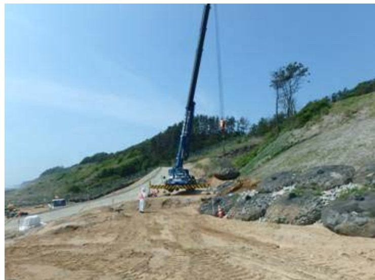
写真② 接続柵部 造成
