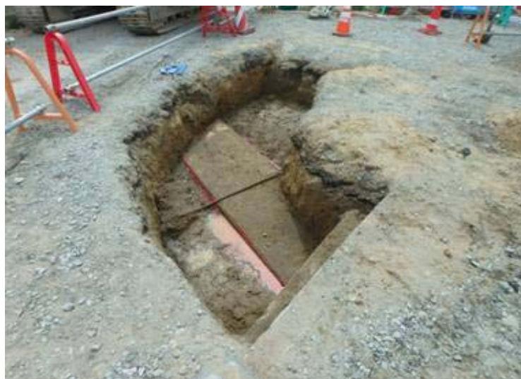
写真① 接続柵部 埋設物調査
