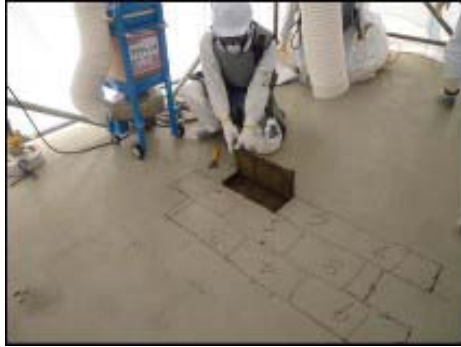
【写真⑤】汚染源撤去開始 (3月30日)
