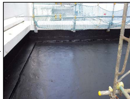
【写真④】仕上げ防水 (4月25日)
