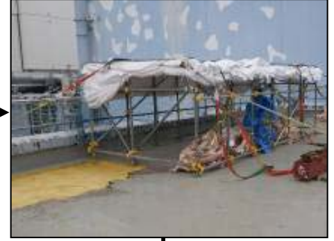
【写真⑧】仮設テント盛替状況 (4月1日)
