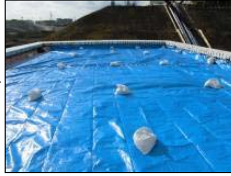
【写真②】ブルーシート設置 (3月2日)
