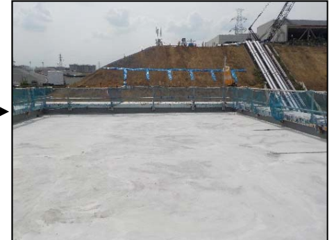
【写真⑫】押さえモルタル打設 (5月28日)
