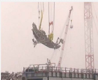
＜燃料交換機撤去作業の状況＞
