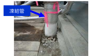
(陸側遮水壁 試験凍結箇所例)
