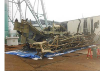
(8/21に撤去した燃料交換機)
