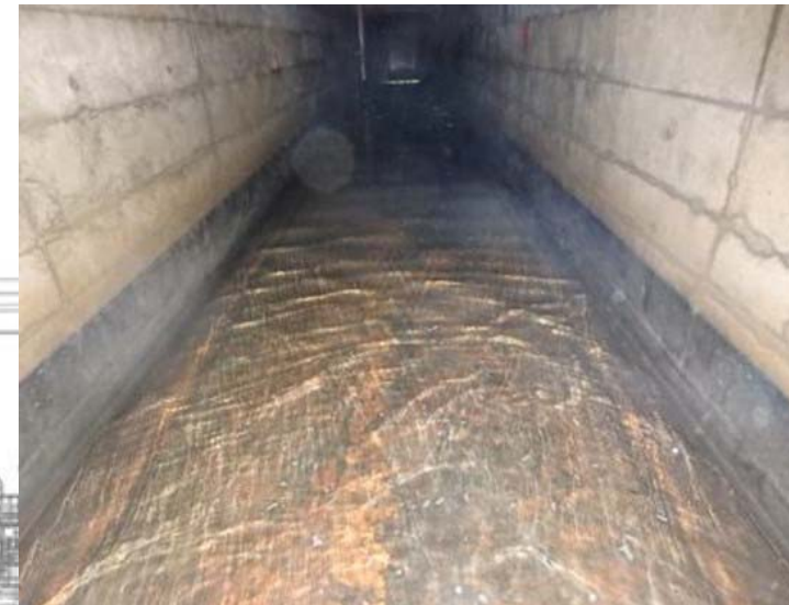
清掃完了状況
