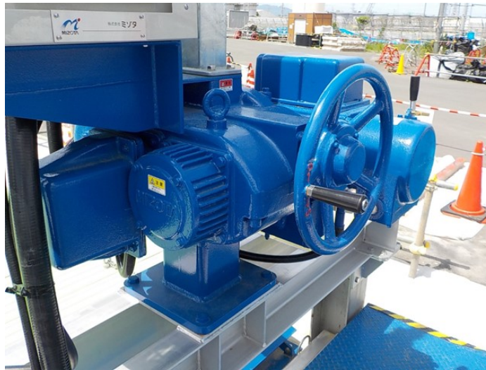
写真 ゲート巻上機電動化状況
