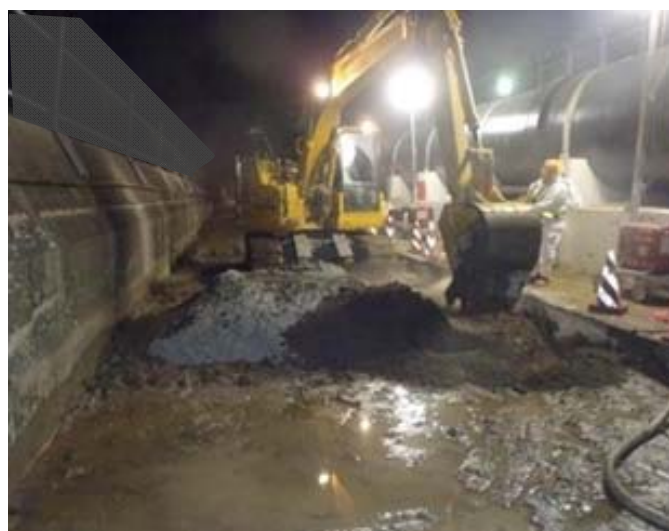
写真② 南護岸部 地盤改良工
