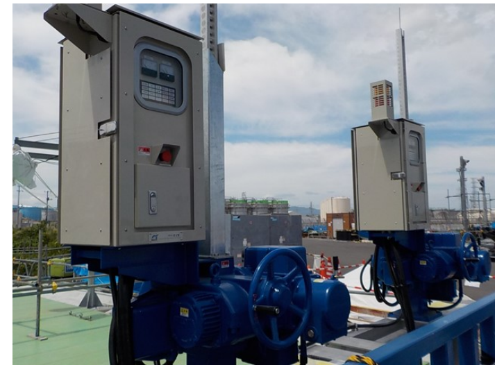
写真 自動・遠隔制御盤設置状況
