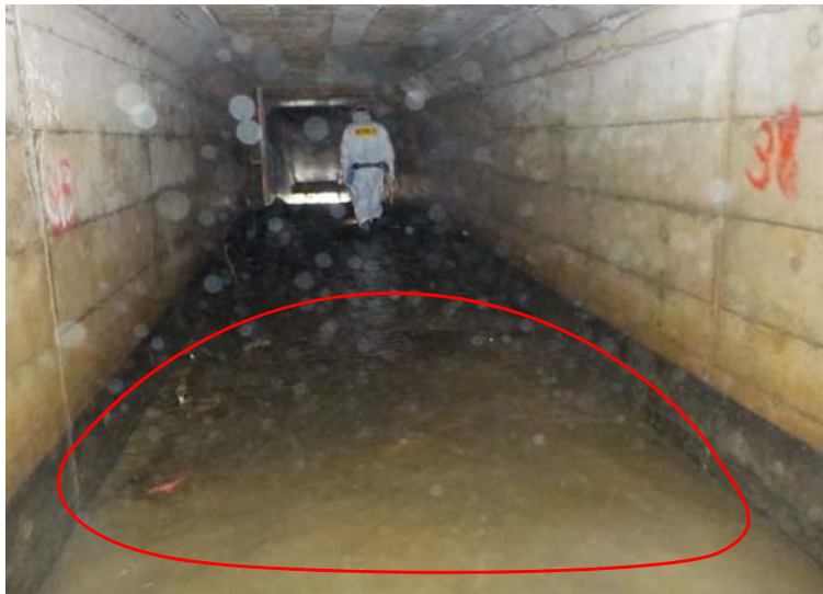
清掃前堆砂状況
