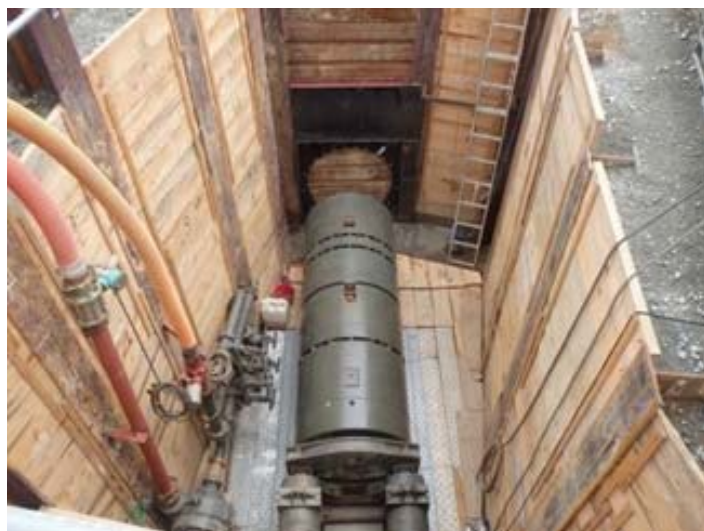
写真① 地下水BPエリア(推進発進立坑・推進機搬入)
