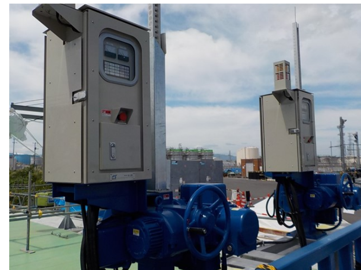
写真 自動・遠隔制御盤設置状況
