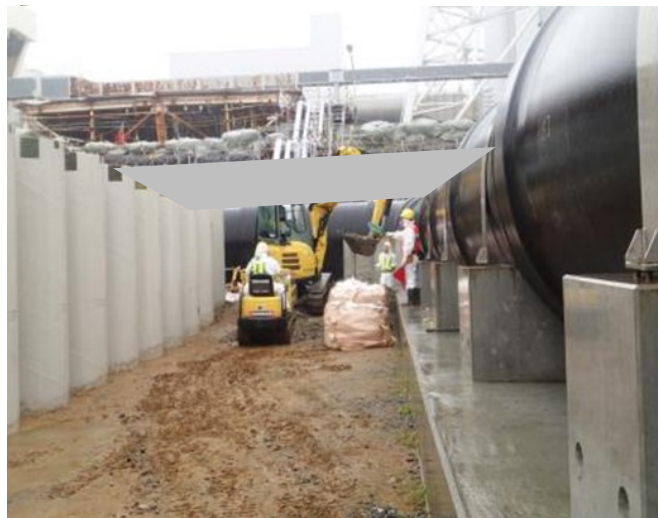
写真② 埋立エリア部 基盤成形
