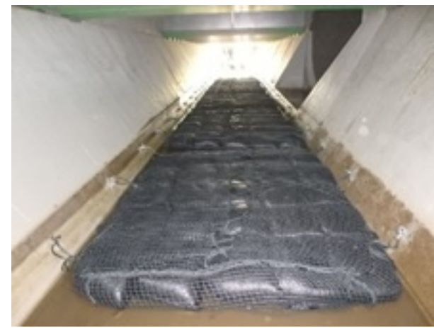
<浄化材の設置>
