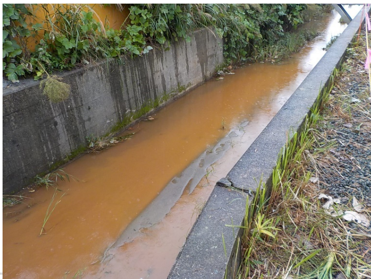
上流部清掃予定箇所
