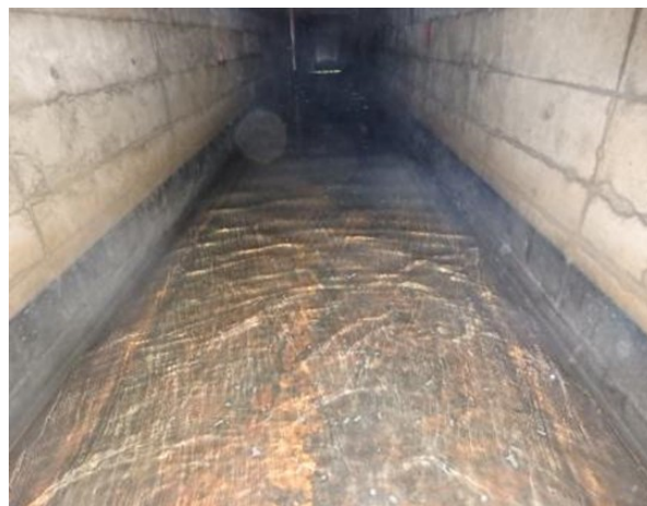
<排水路清掃状況>
