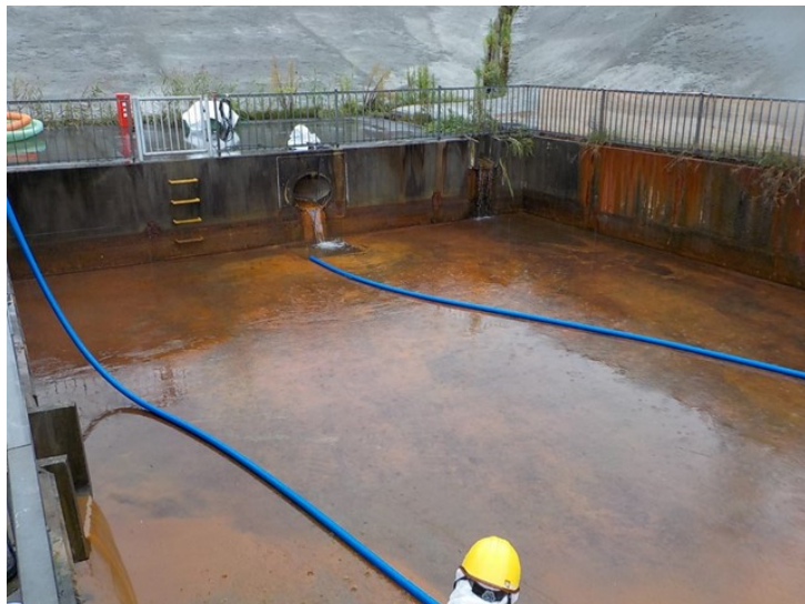
上流部清掃状況
