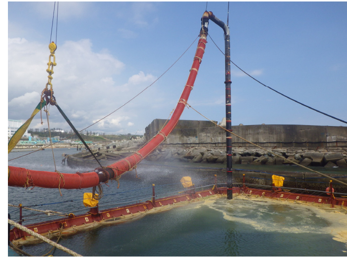
根固石の被覆イメージ
