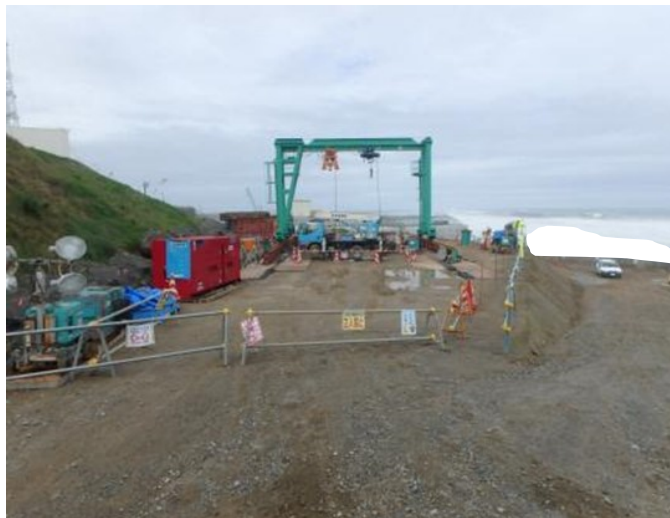
写真① 発進立坑部 門型クレーン設置
