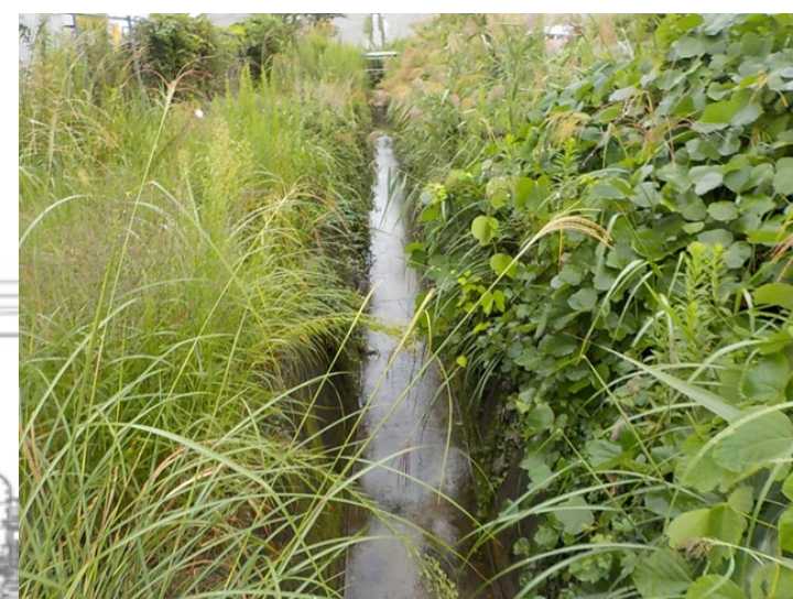
上流部清掃予定箇所
