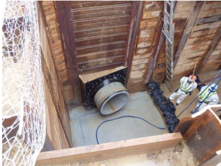
写真① 地下水BPエリア 推進管路到達
