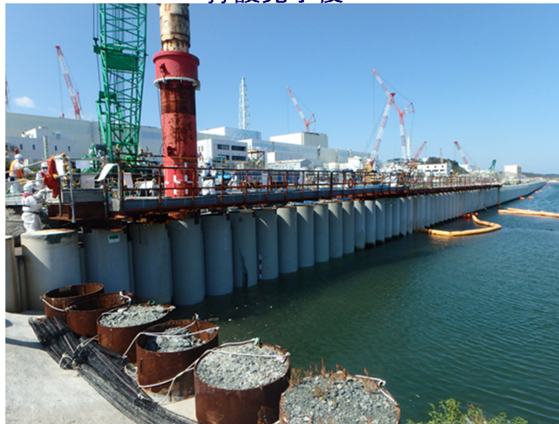
鋼管矢板打設完了後
