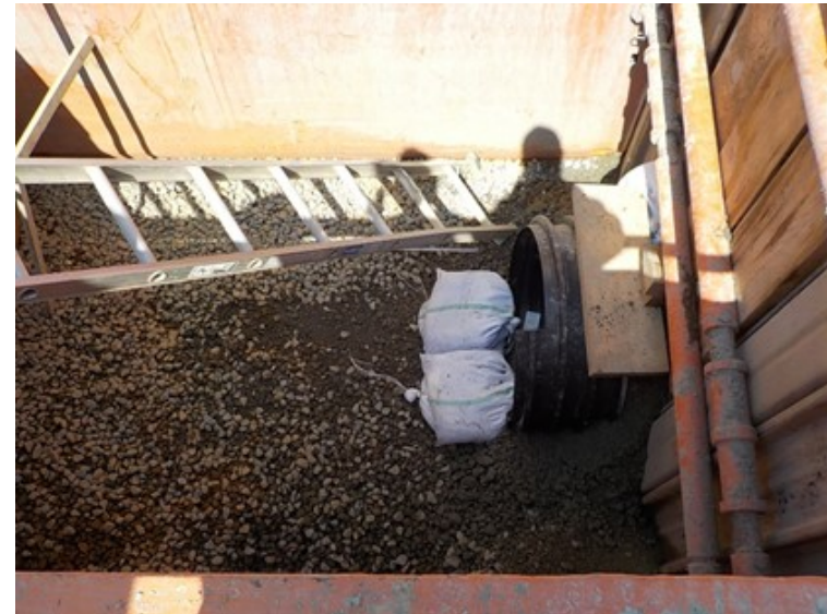
写真④ 大熊通り 排水管路構築
