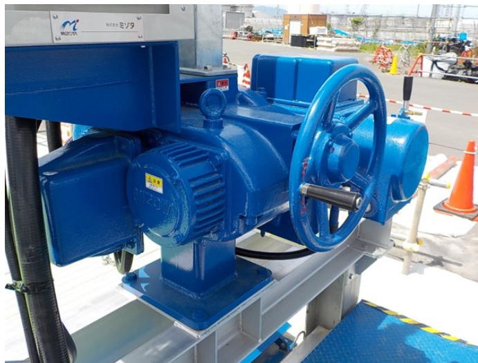
写真 ゲート巻上機電動化状況
