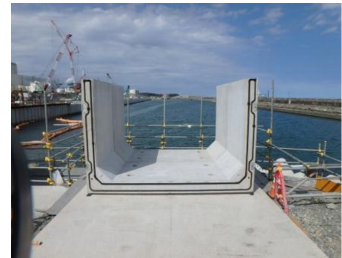
写真③ 放流口部 放流口開渠設置
