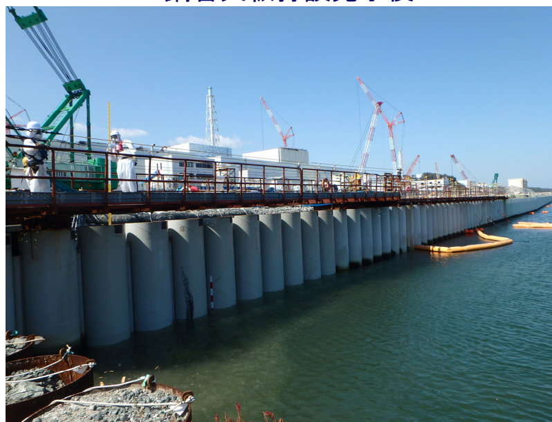
鋼管矢板打設完了後
