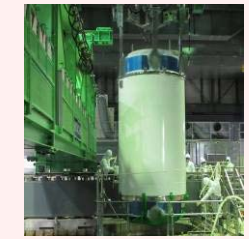
燃料取り出し状況
