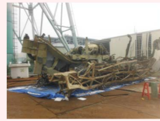
撤去した燃料交換機
