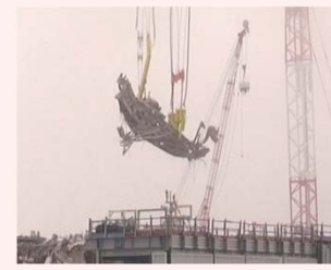
8/2 燃料交換機撤去作業の様子
