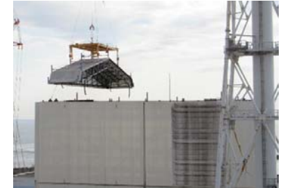
(1号機建屋カバー解体作業の状況)
