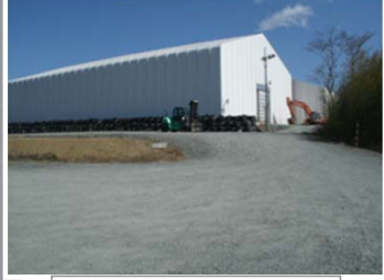
瓦礫保管テント
