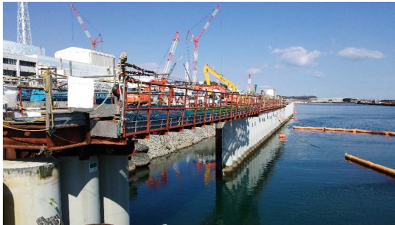
<鋼管矢板打設前>
