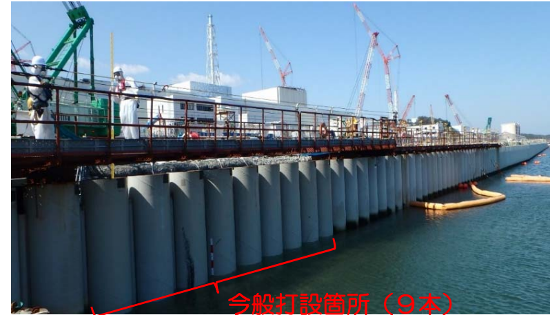
<鋼管矢板打設完了後>
