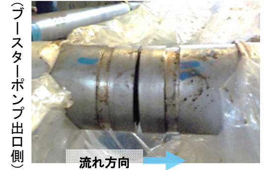
③ 継手取付部配管 目視点検状況 (ハウジング及びゴムリングとの接触部に、傷、腐食等の異常なし)
