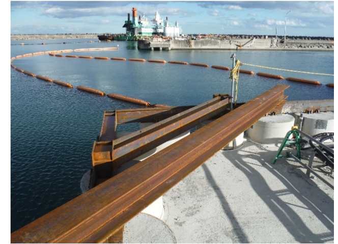
【コーナー部における杭頭結合状況】
