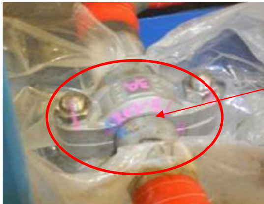
ブースターポンプ出口配管継手部
