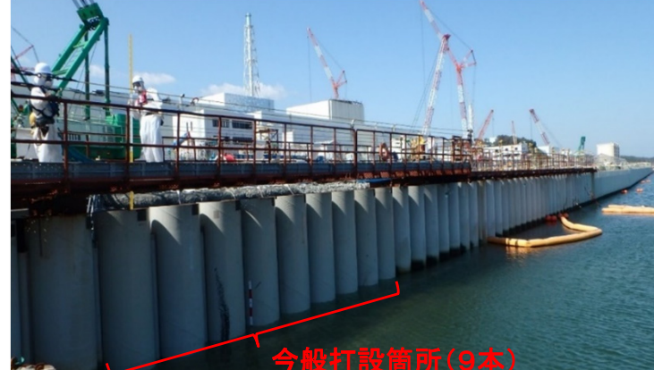
＜鋼管矢板打設完了後＞
