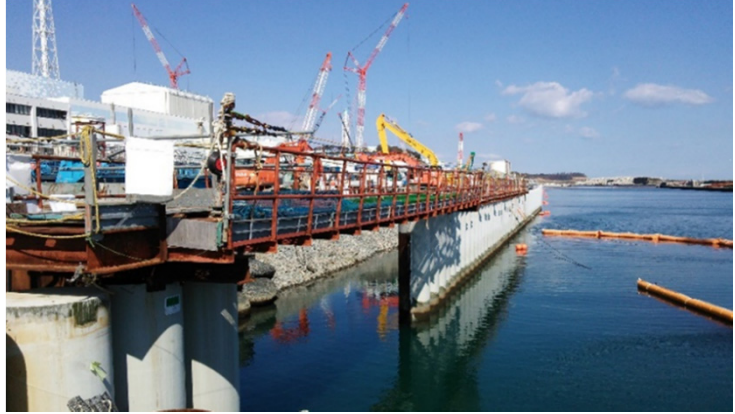
＜鋼管矢板打設前＞
