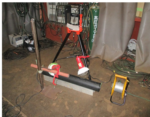
再現試験状況
