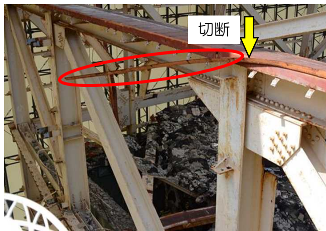
支障となる鉄骨等の例
